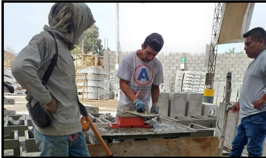
Fig. 8 Vibración de Unidad de Albañilería PET
