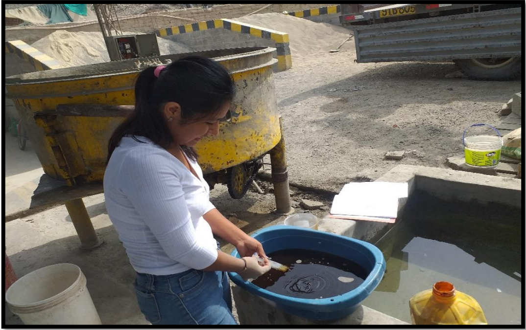
Anexo N°7 Dosificación de Agua y aditivo para mezcla de Concreto.
