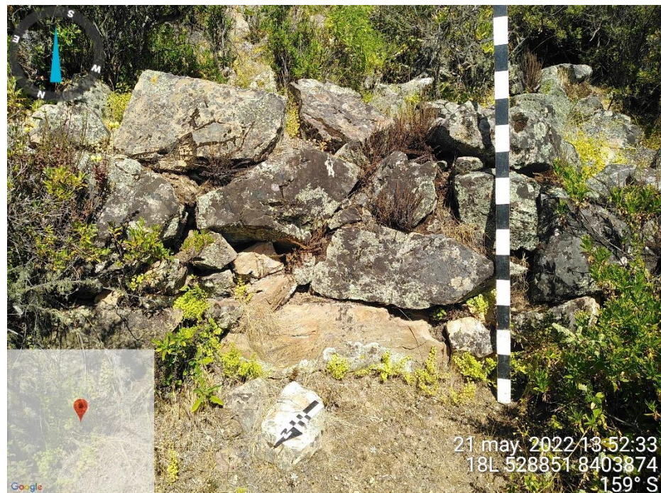
Fig. 170. Ejemplo de un muro con mayor altura. Recintos amplios (Ec-3/SI).
