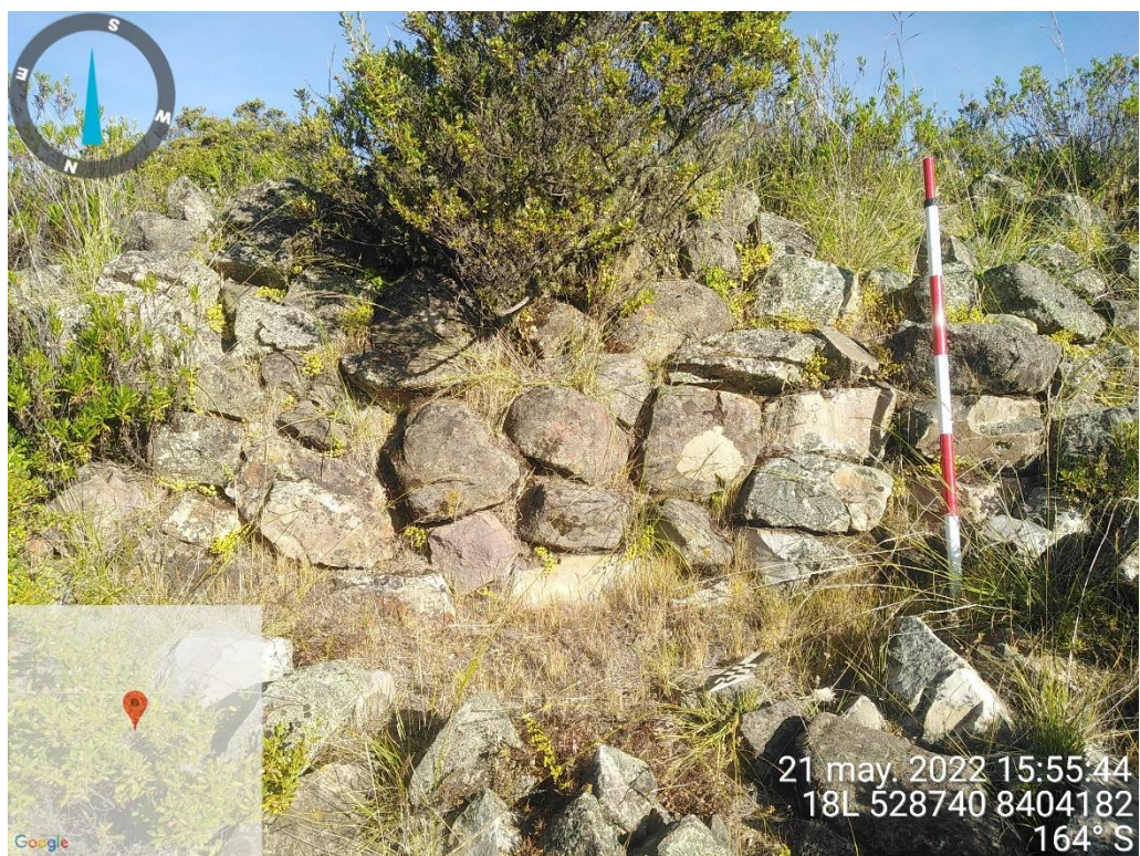
Fig. 55. Paramento exterior con mampostería bien trabajada. Lado norte de los Barrios (Ec-1/SII). Toma de norte a sur.
