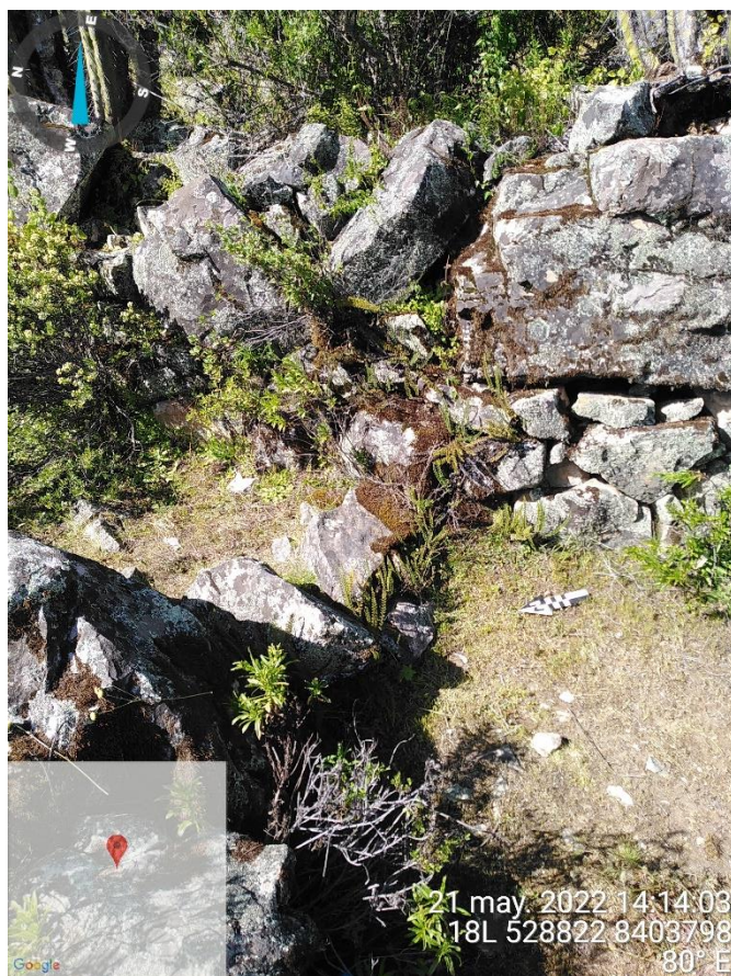
Fig. 22. Muros de los Recintos amplios (Ec-3/SI) adosados a los Barrios (Ec-2/SI). Toma de oeste a este.
