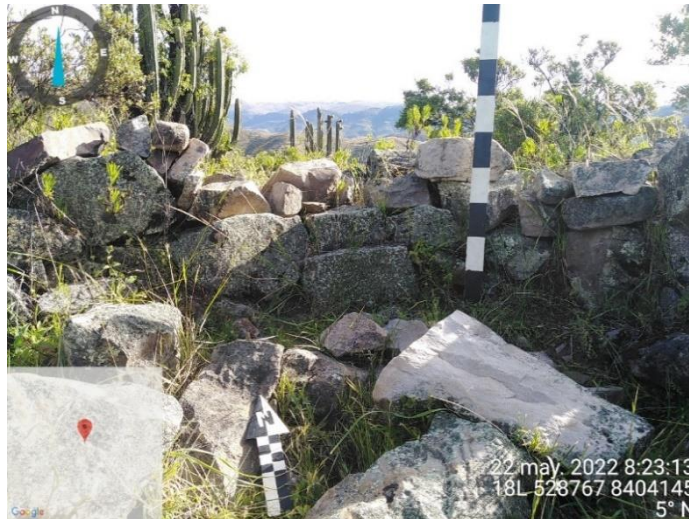
Fig. 160. Muros con mampostería careada uniforme, “semilabrada”. Paramento interior de los Barrios, lado norte (Ec-1/SII).
