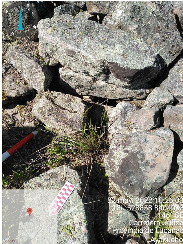
Fig. 75. Detalle del vano de acceso clausurado de la Chullpa (Ec-4/SII).
