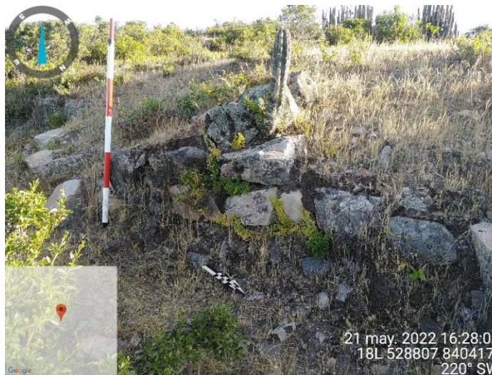
Fig. 162. Muros con mampostería careada uniforme. Terrazas (Ec-3/SII).
