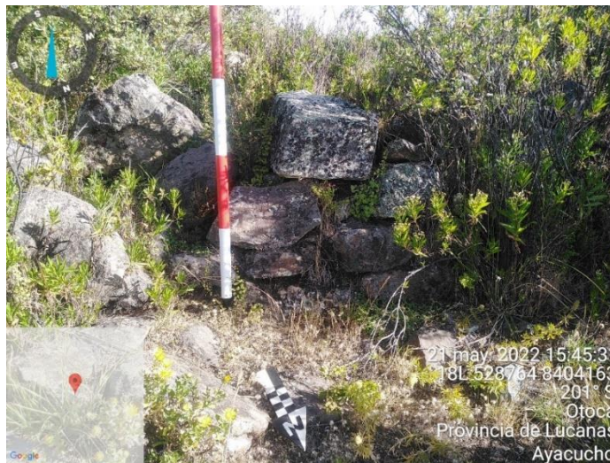
Fig. 161. Muros con mampostería careada uniforme, “semilabrada”. Paramento interior de los Barrios, lado norte (Ec-1/SII).
