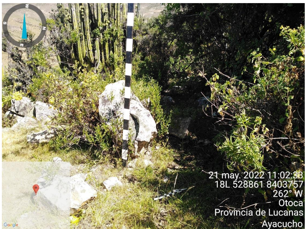
Fig. 48. Vano de acceso en el lado noroeste de la Plaza 2 (Ec-8/SI). Toma de este a oeste.
