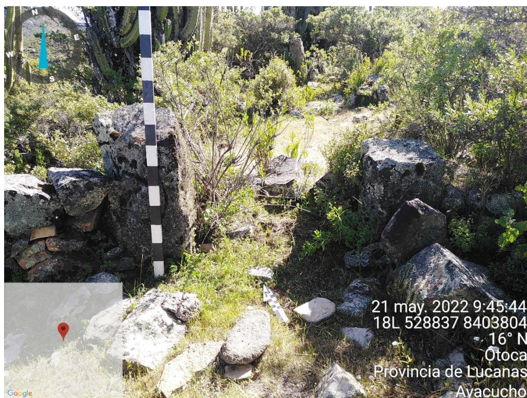
Fig. 99. Generalidad de un vano de acceso en el asentamiento Sanky Orqo. Toma de sur a norte. (Ec-2/SI).
