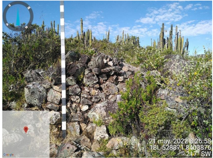
Fig. 157. Muros con mampostería careada uniforme. Barrios norte (Ec-2/SI).
