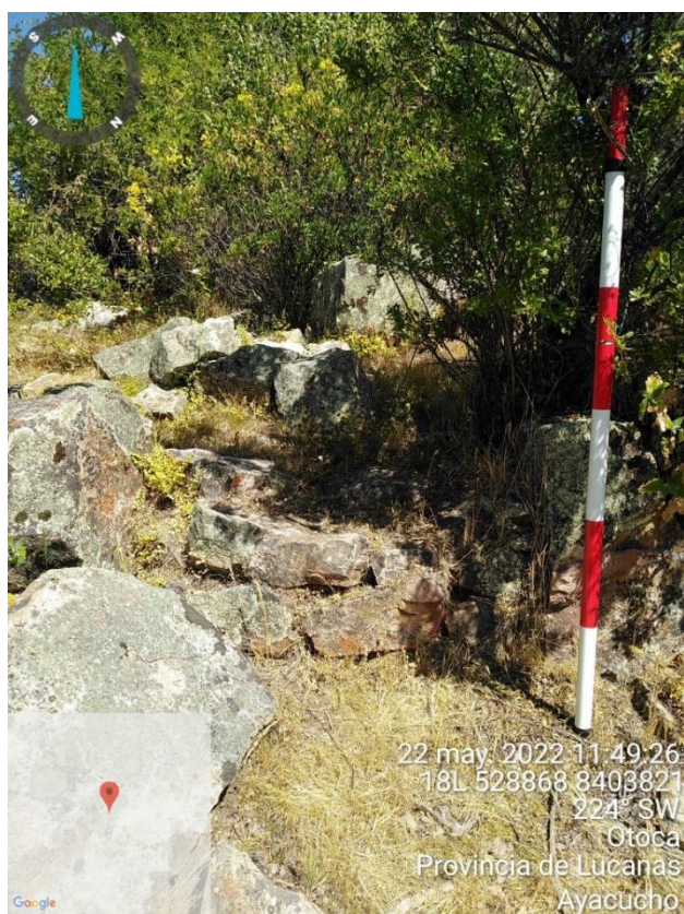
Fig. 180. Vano de acceso sellado en la parte alta de los Barrios (Ec-2/SI).
