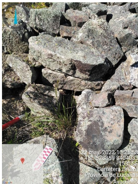
Fig. 177. Vano de acceso de la Chullpa (Ec-4/SII).
