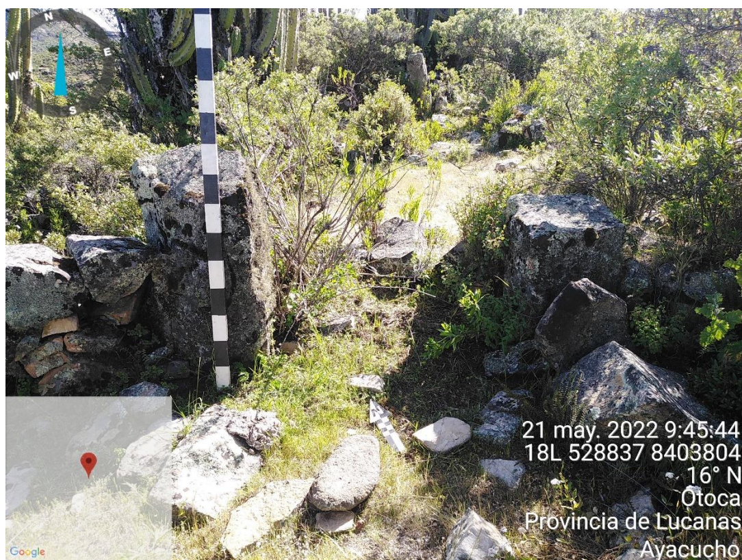
Fig. 17. Detalle de un vano de acceso en el Barrio sur (Ec-2/SI). Toma de sur a norte.
