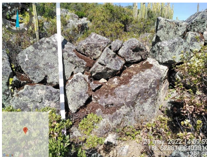
Fig. 165. Muros con tendencia hacia una mampostería careada. Recintos amplios (Ec-3/SI).
