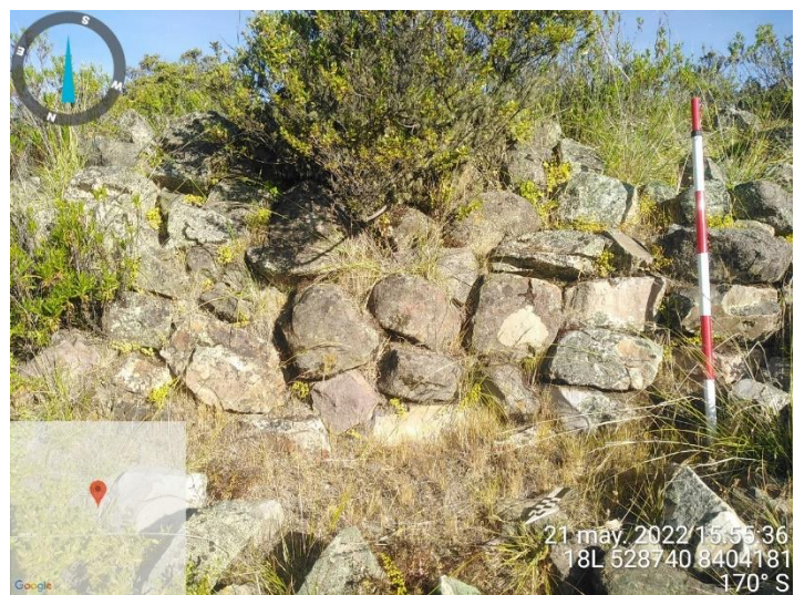
Fig. 159. Muros con mampostería careada uniforme, “semilabrada”. Paramento exterior de los Barrios, lado norte (Ec-1/SII).
