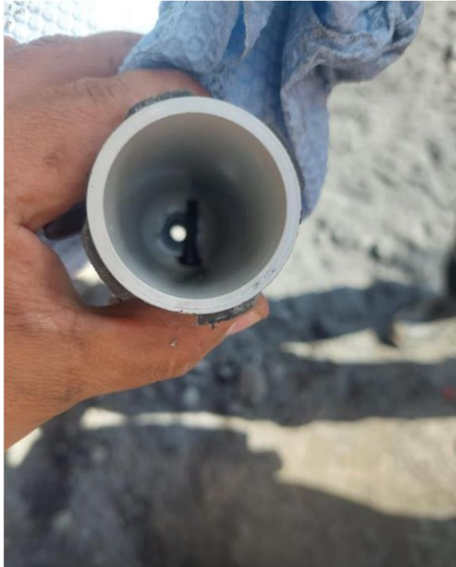
Fig. 15: Limpieza interna de ductos de compresor (PM 250horas)
