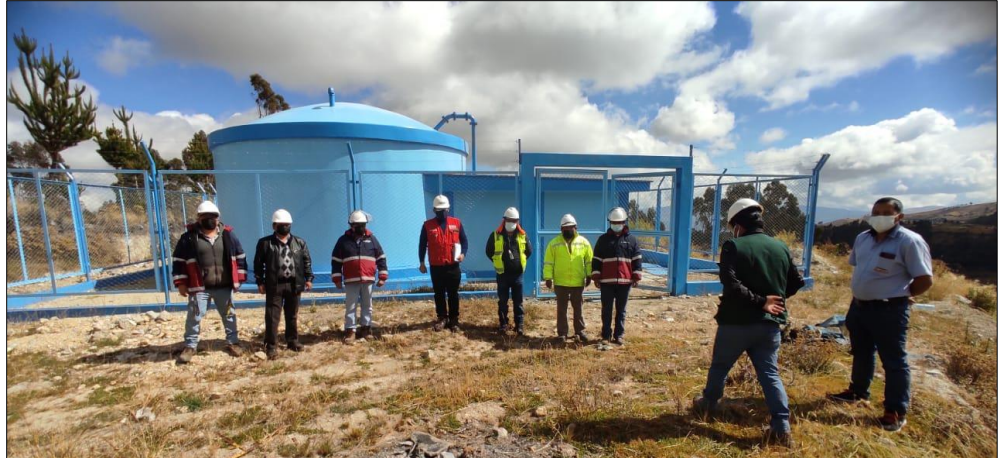
Fotografía N°07: Vista panorámica de reservorio
