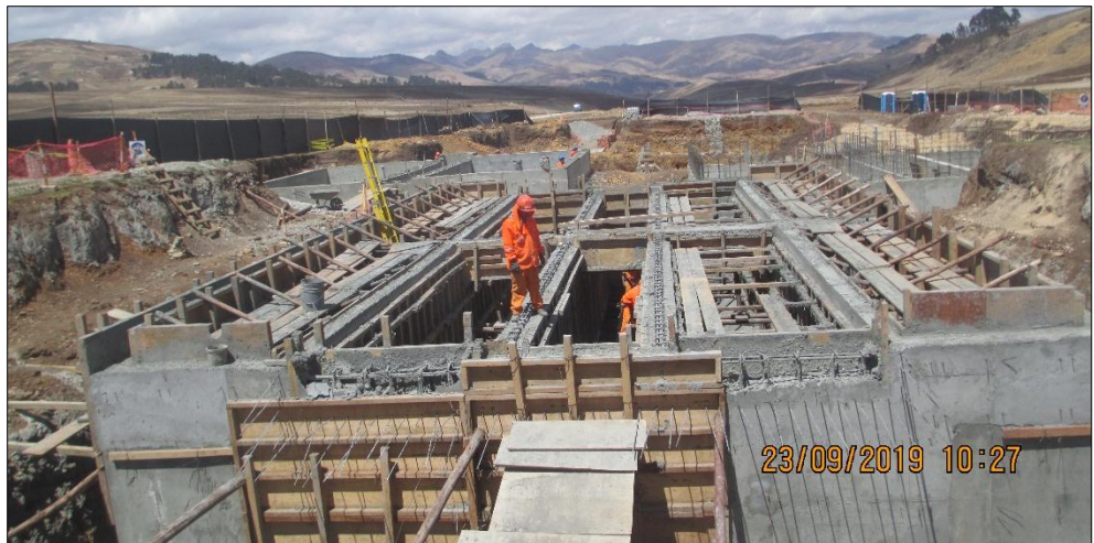
Fotografía N°09: Verificación de Desencofrado de tanque IMHOF (PTAR)
