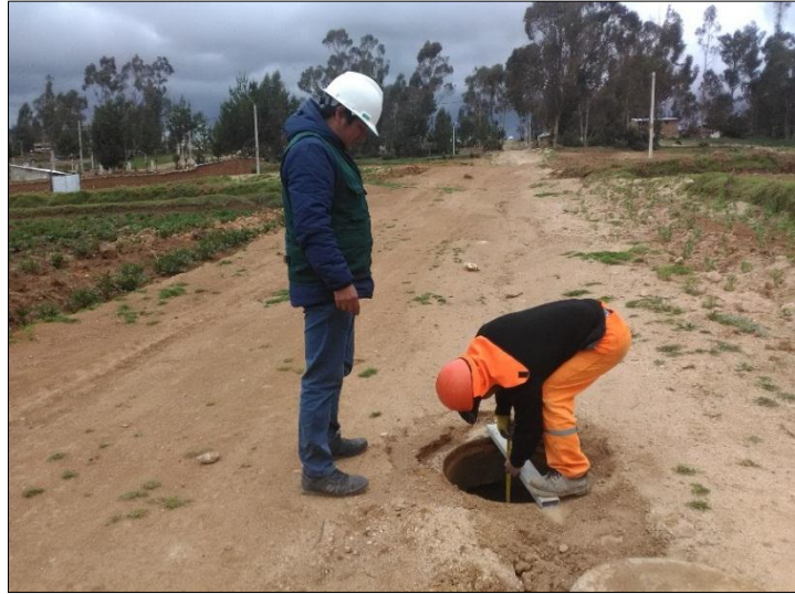
Fotografía N°01: Verificación de Prueba hidráulica en red de alcantarillado
