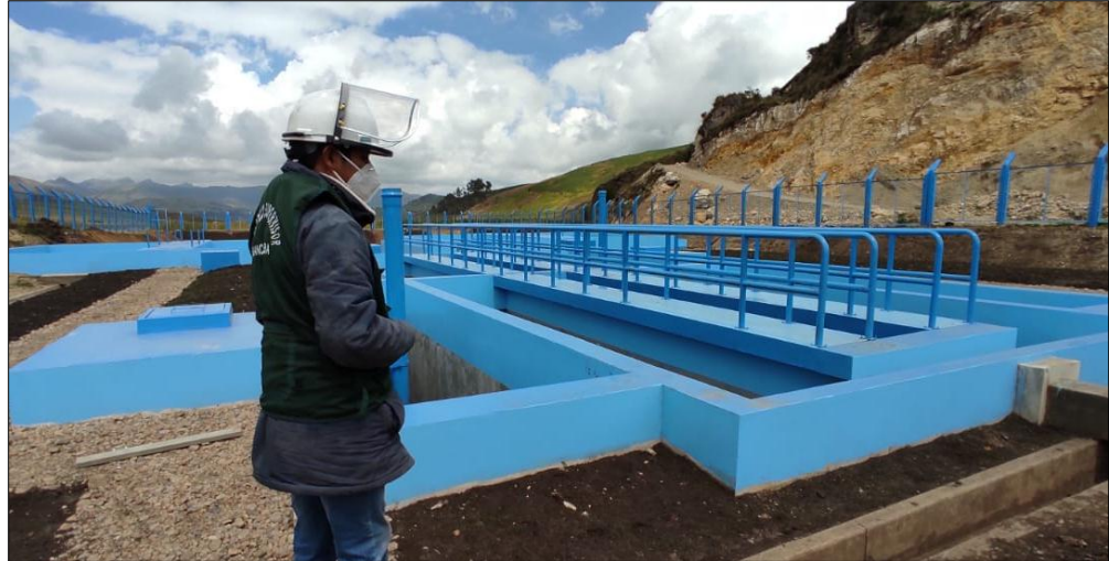
Fotografía N°10: Verificación de acabados finales PTAR
