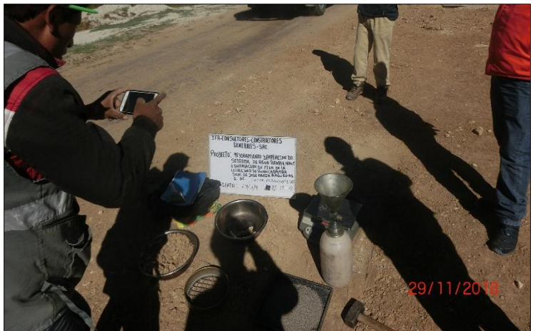
Fotografía N°21: Verificación de ensayo de densidad de campo en relleno de zanja de red de alcantarillado
