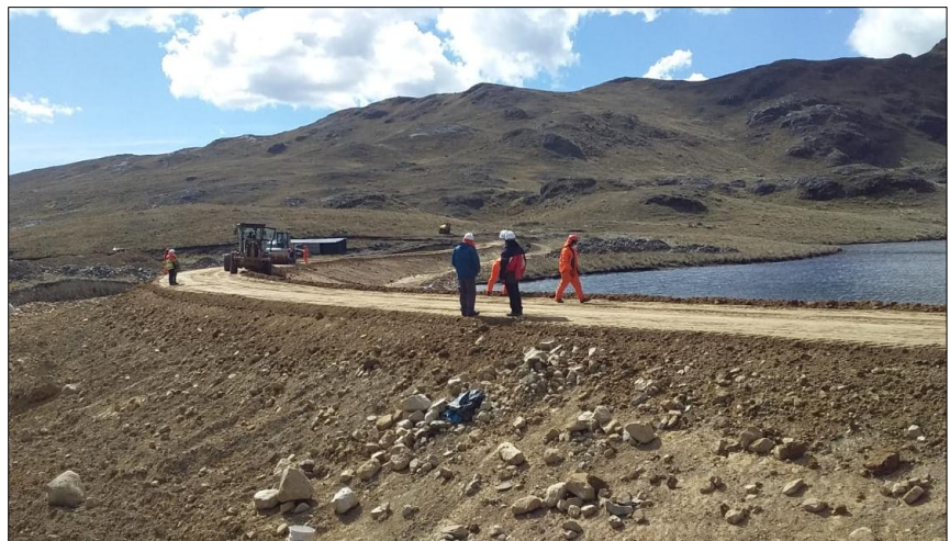
Fotografía N°12: Verificación de conformación de DIQUE de presa - captación
