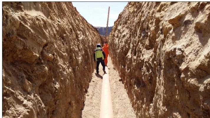
Fotografía N°03: Verificación de Colocación de tubería de red de alcantarillado
