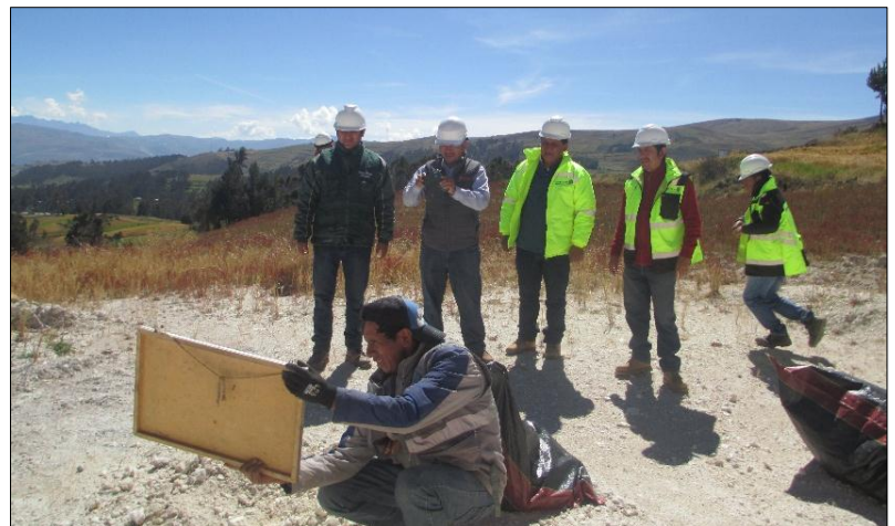
Fotografía N°24: Verificación de ensayo de densidad de campo en nivel de cimentación de PTAP
