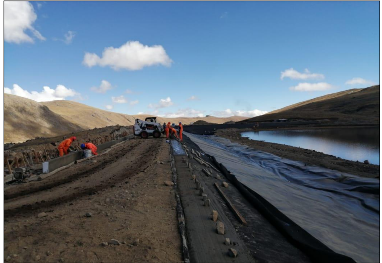
Fotografía N°13: Verificación de Colocación de geotextil en el dique de presa
