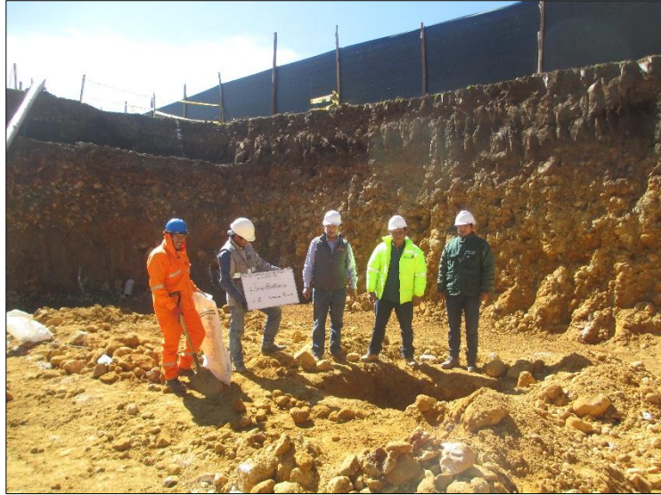
Fotografía N°25: Calicata para verificación de estudio de suelos en PTAR
