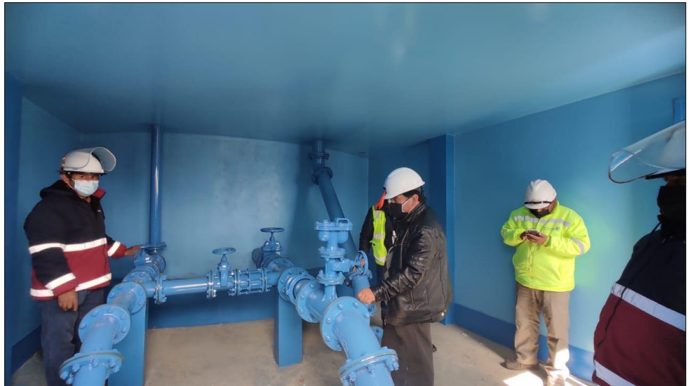
Fotografía N°08: Verificación de caseta de válvula de reservorio
