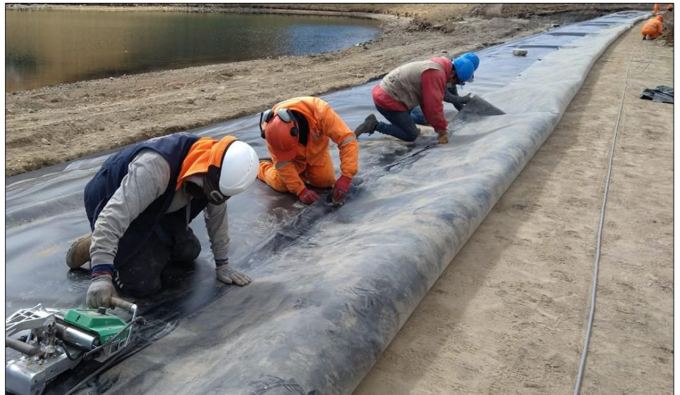
Fotografía N°14: Verificación de Colocación de geomembrana en el dique de presa
