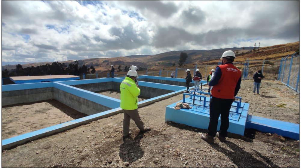
Fotografía N°16: verificación de PTAP
