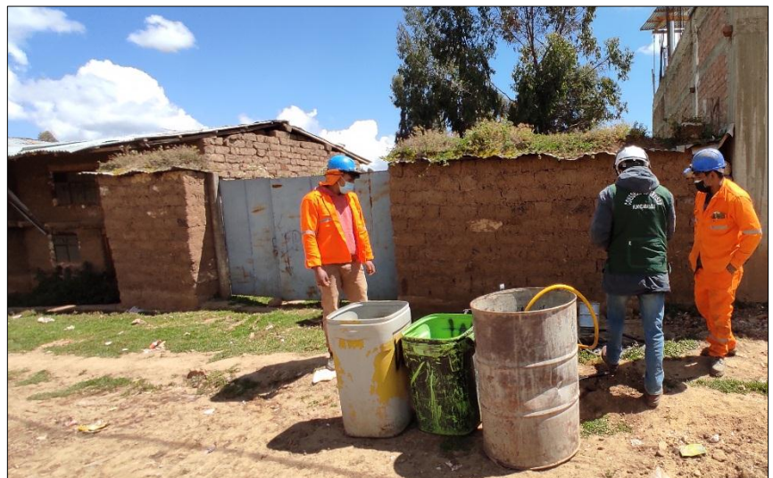
Fotografía N°18: Verificación de prueba hidráulica en conexiones domiciliarias de agua potabl
