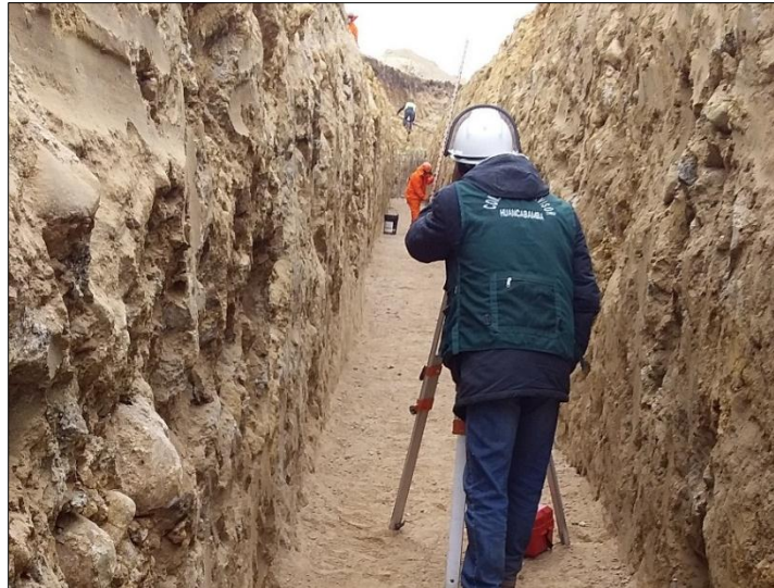
Fotografía N°02: Verificación de pendiente de red de alcantarillado
