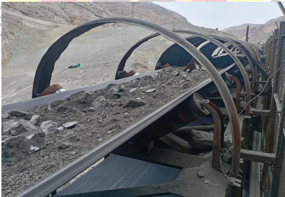
Figura 25. Foto actual de cobertura a retirar
