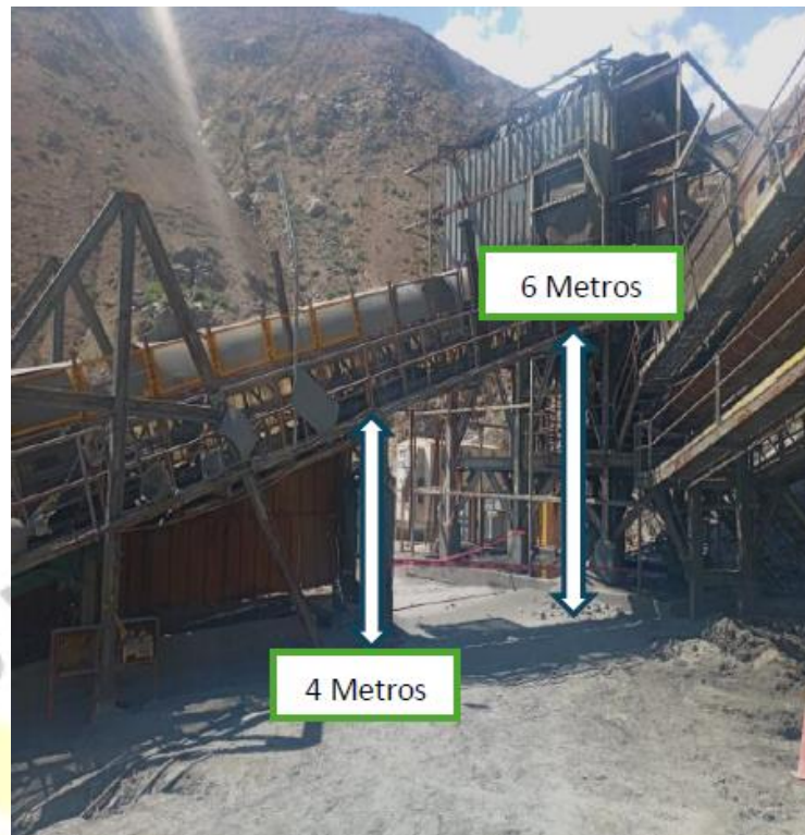
Figura 10. Zona 2 - Tramo 3 – Faja 4
