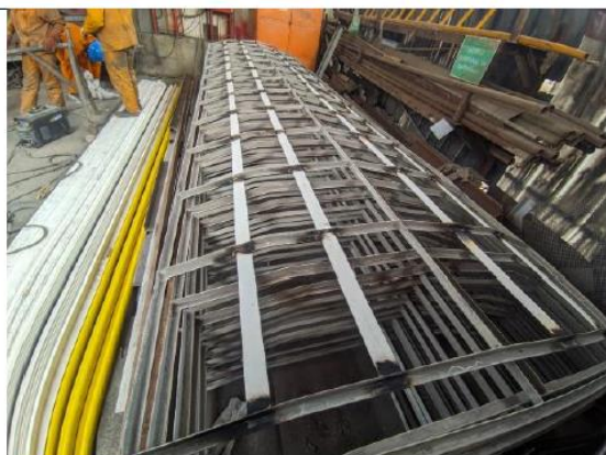
Ilustración 1: Fabricación de estructuras metálicas
