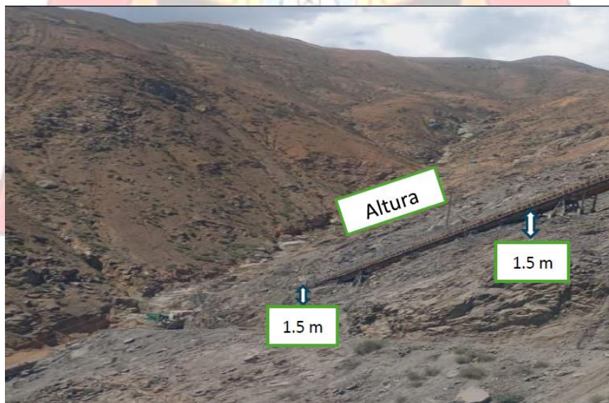
Figura 15. Zona 3- Tramo 5 - Faja 5
