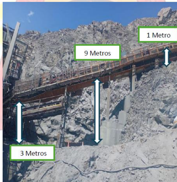
Figura 11. Zona 2 - Tramo 4 – Faja 5
