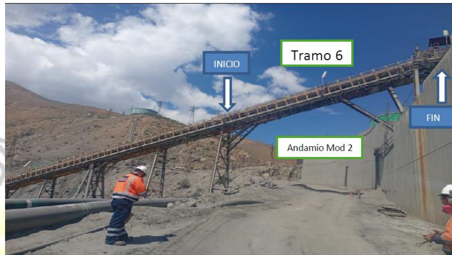
Figura 16. Vista panorámica de ubicación del tramo para reemplazo de cobertura inferior
