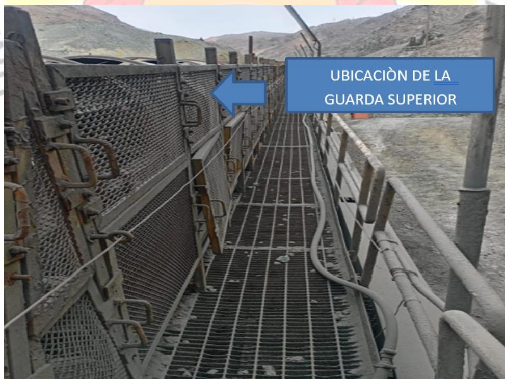
Figura 23. Señalización de la ubicación de guardas a retirar
