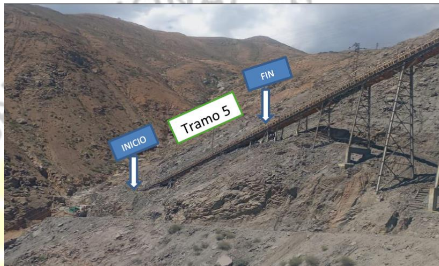
Figura 14. Vista Panorámica de Ubicación del tramo para reemplazo de cobertura inferior
