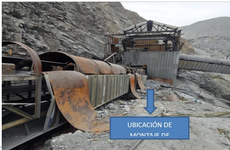
Figura 22. Zona de montaje de andamios
