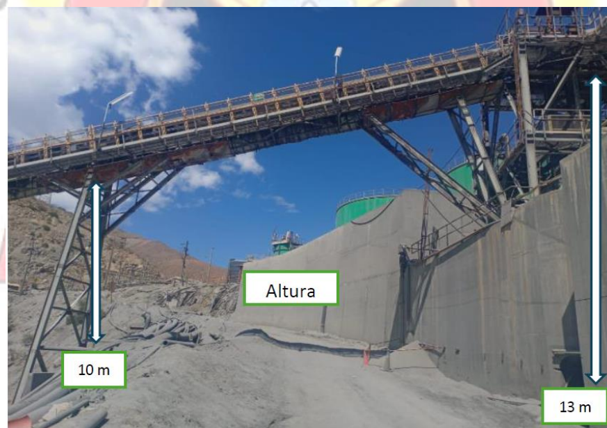
Figura 17. Zona 4 Tramo 6 - Faja 5
