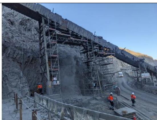
Ilustración 3: Montaje de andamios
