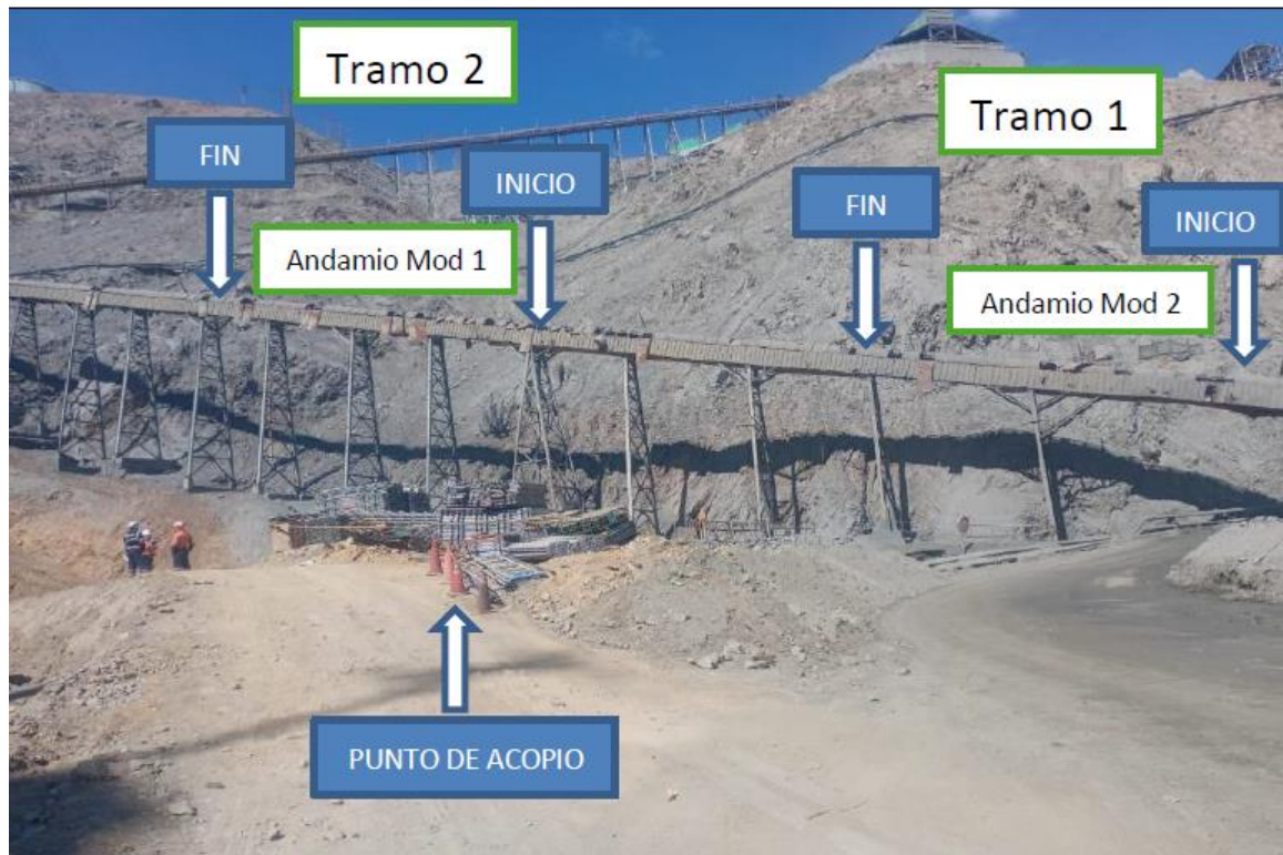
Figura 2. Vista panorámica de ubicación de los tramos para reemplazo de cobertura
