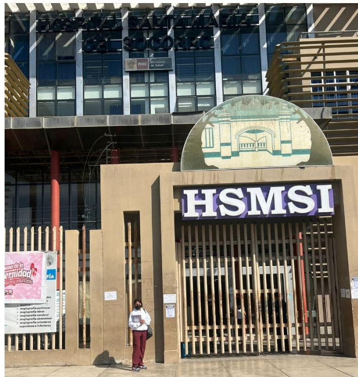
Descripción: Fachada del Hospital Santa María del Socorro de Ica.
