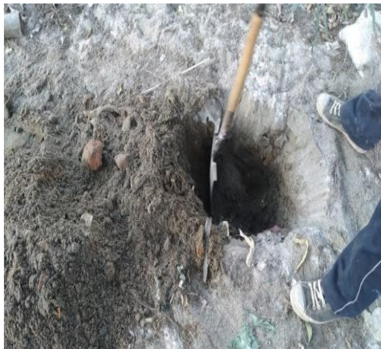
Figura 12: Excavación de calicatas a 30cm
