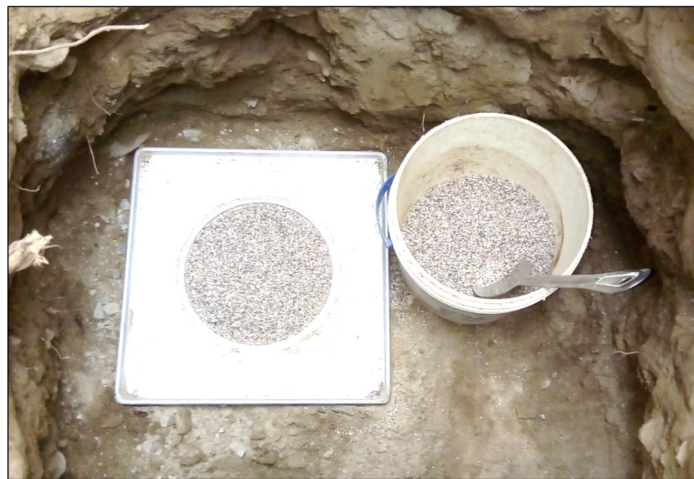
Llenado de la arena graduada en el orificio
