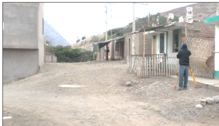
Levantamiento topográfico en la Calle Arequipa
