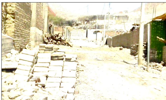
Vista panorámica de la Calle 5
