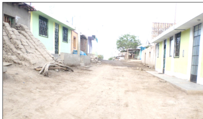
Vista panorámica de la Calle Rimac
