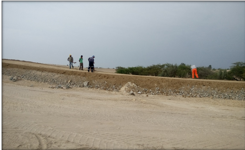
Fig. 15 Mejoramiento de sub rasante
