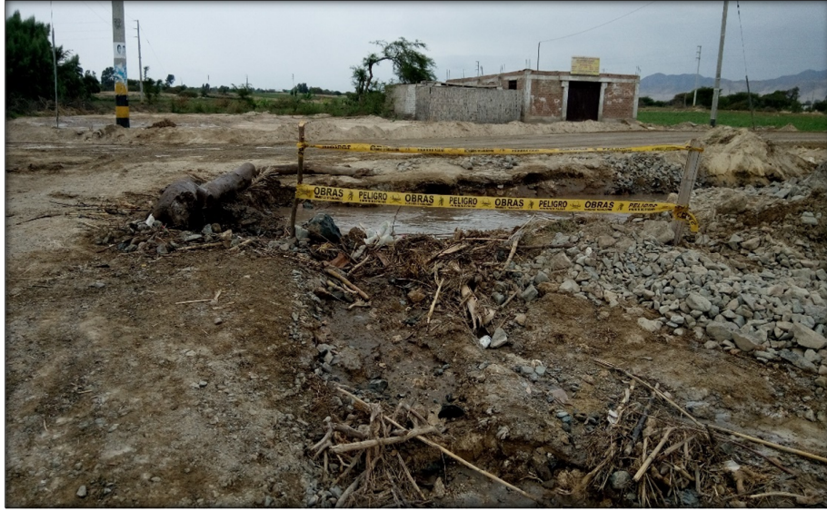
Fig. 16 Demolición de estructura existente
