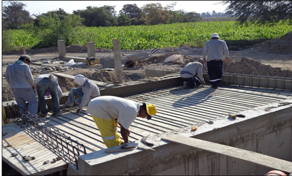
Fig. 18 preparación de losa de techo de pontón
