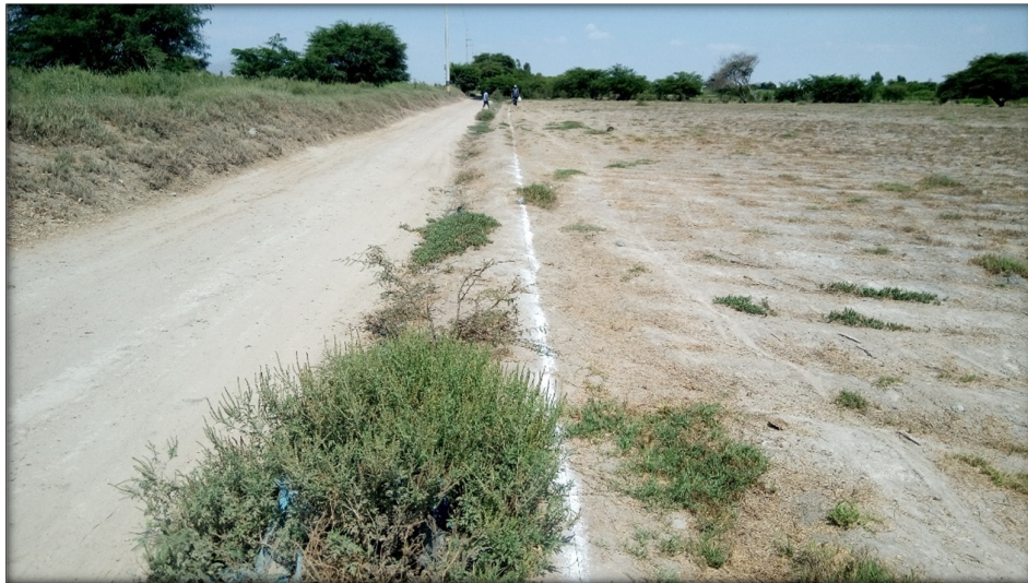
Fig. 13: Trazo del ancho del camino vecinal
