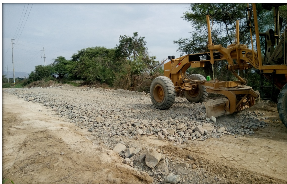
Fig. 14: Mejoramiento de Sub Rasante con piedra over
