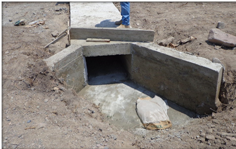
Fig. 17 Mejoramiento de aliviadero de emboquillado
