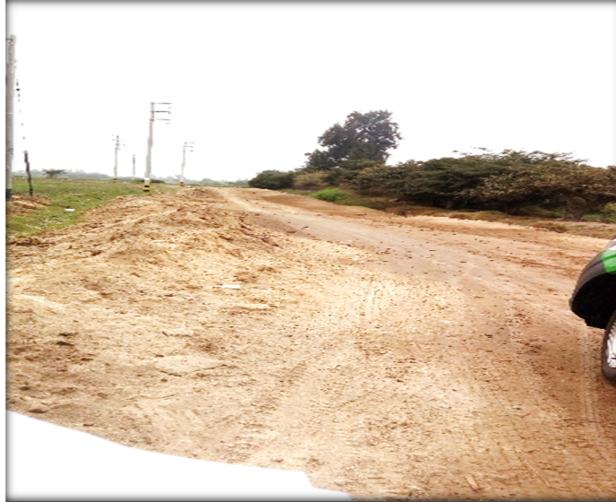
Fig. 4 – Estado actual del camino vecinal
