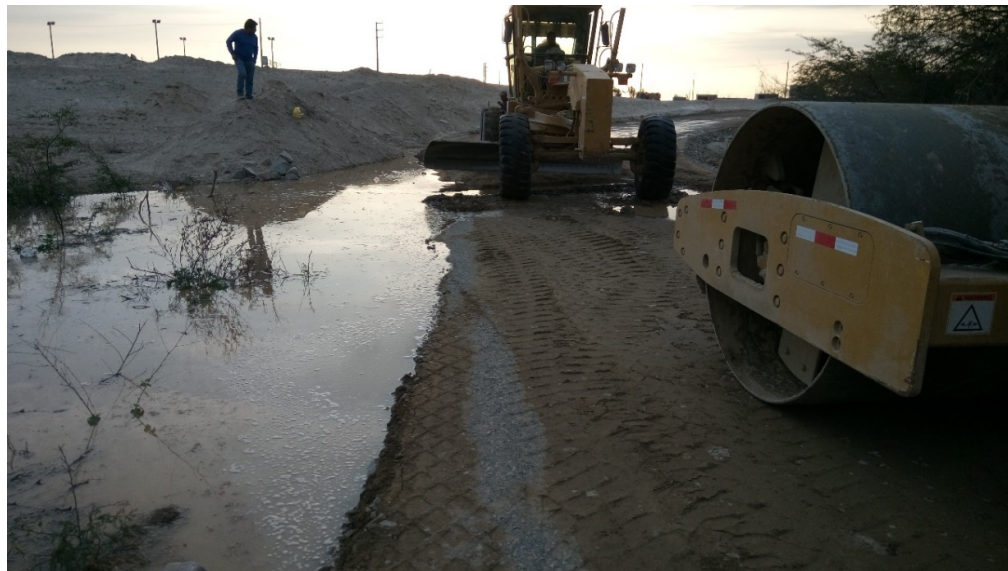
Fig. 19 Riego para mitigación de polvo en área de proyecto
