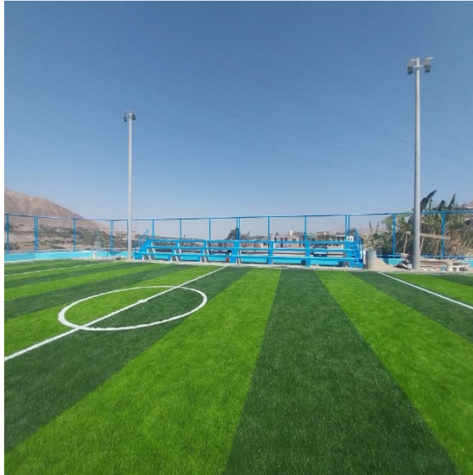
Fig. 86. Vista de la obra entregada
