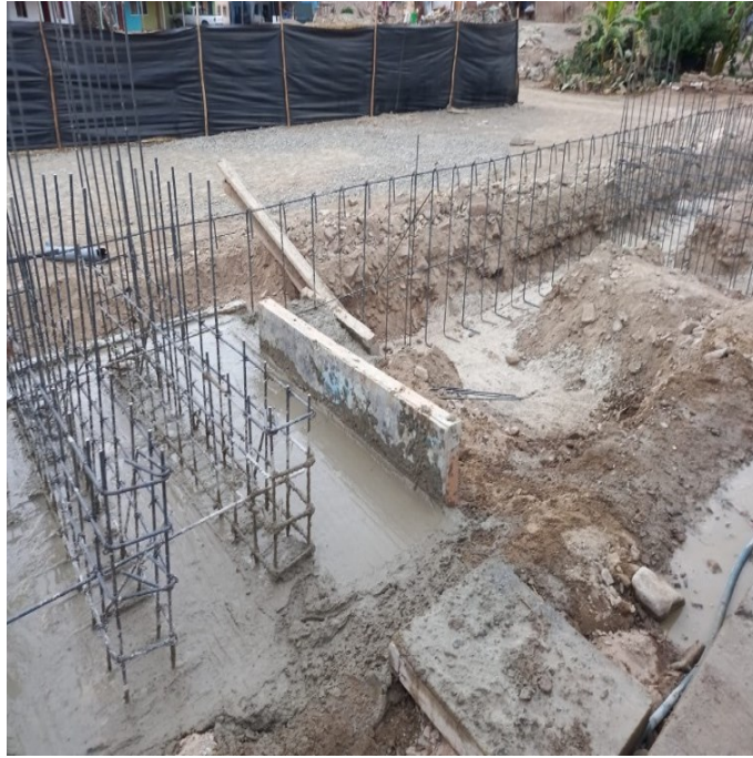
Fig. 44. Verificación de los trabajos de sobrecimiento reforzado-sector 3
