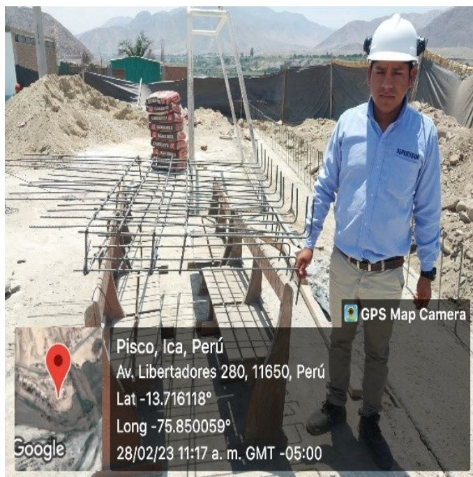
Fig. 31. Vista de la verificación del armado del acero para estructuras proyectadas
