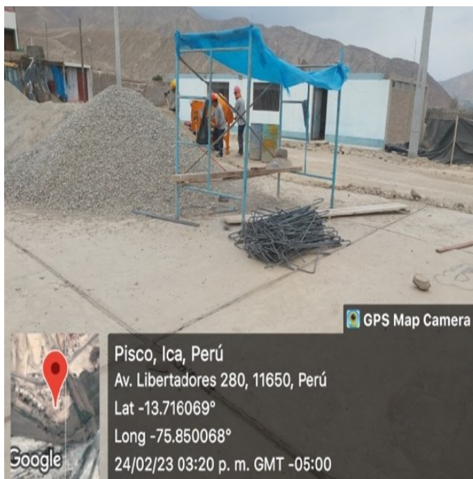
Fig. 36. Vista de la verificación de los materiales para mezcla de estructuras proyectadas
