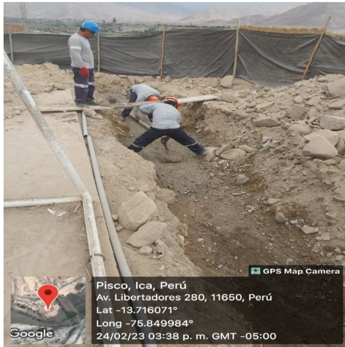
Fig. 39. Verificación de los trabajos de vaciado
