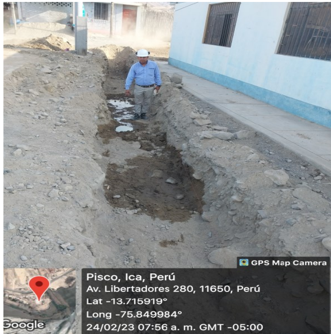
Fig. 26. Vista de la zona donde se encontró la tubería de agua
