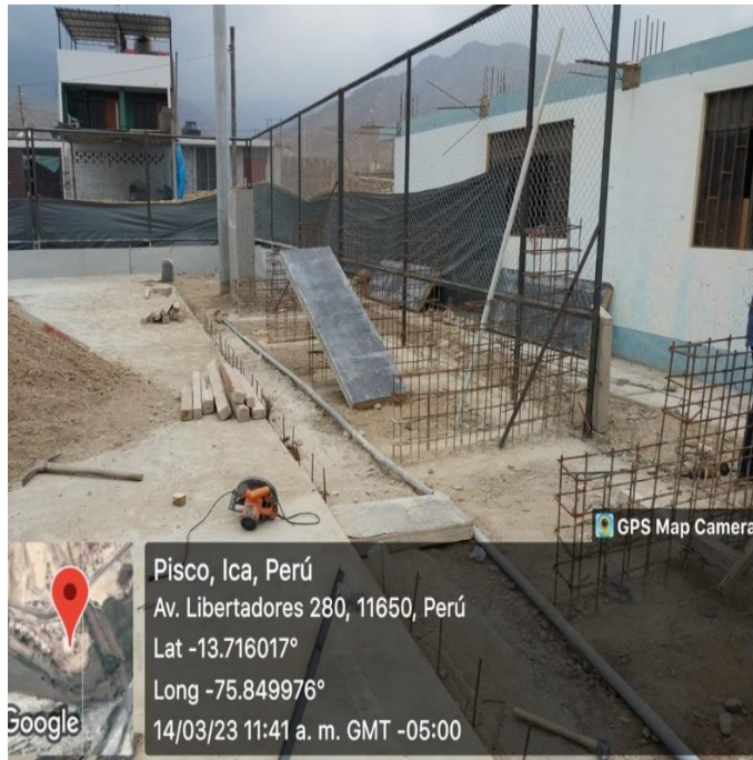
Fig. 62. Armado de acero de placas de tribunas
