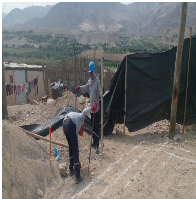
Fig. 14. Vista de la ubicación y colocación del cerco perimétrico
