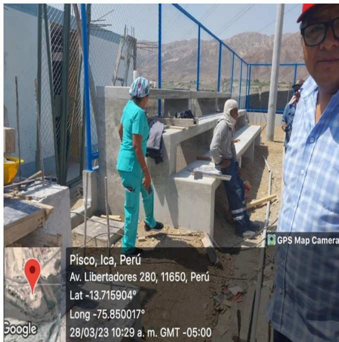
Fig. 73. Vista de la verificación de los paños superiores ya vaciados
