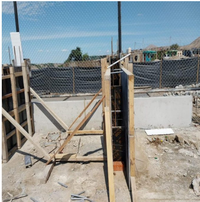
Fig. 61. Armado de acero de placas de tribunas
