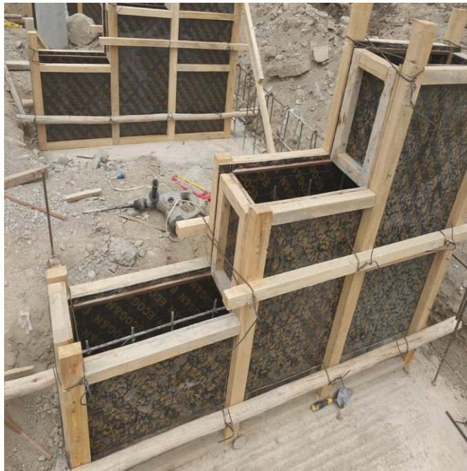
Fig. 65. Verificación del encofrado de las placas
