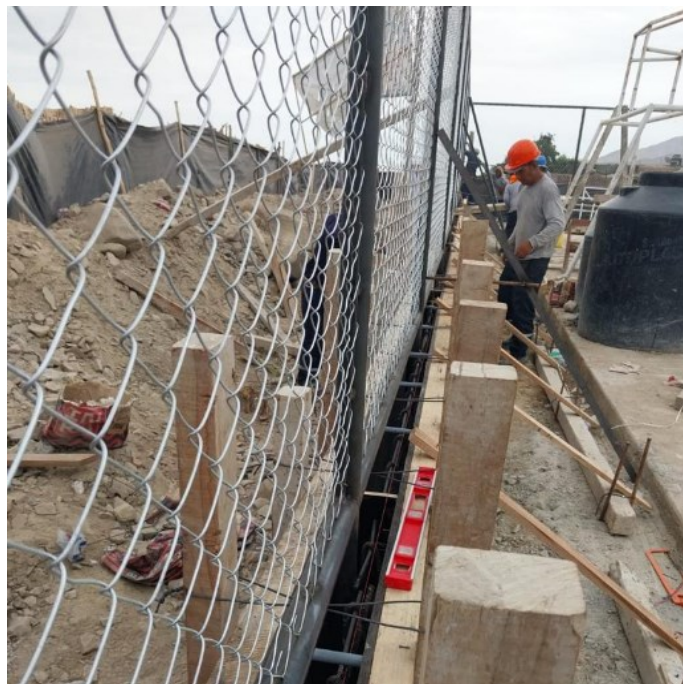
Fig. 55. Armado del encofrado para la base de los apoyos del cerco con malla galvanizada
