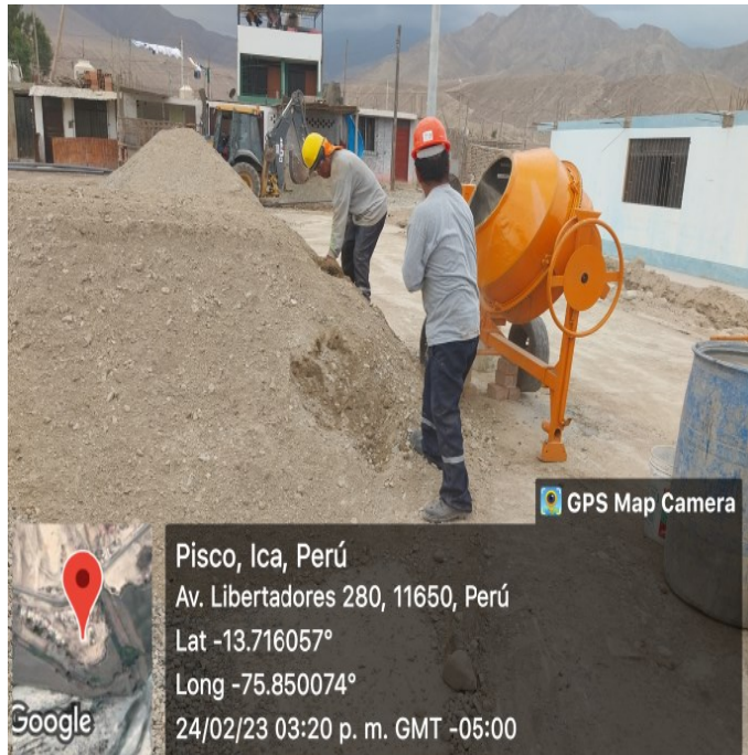
Fig. 37. Vista de la verificación y control de la mezcla de estructuras proyectadas
