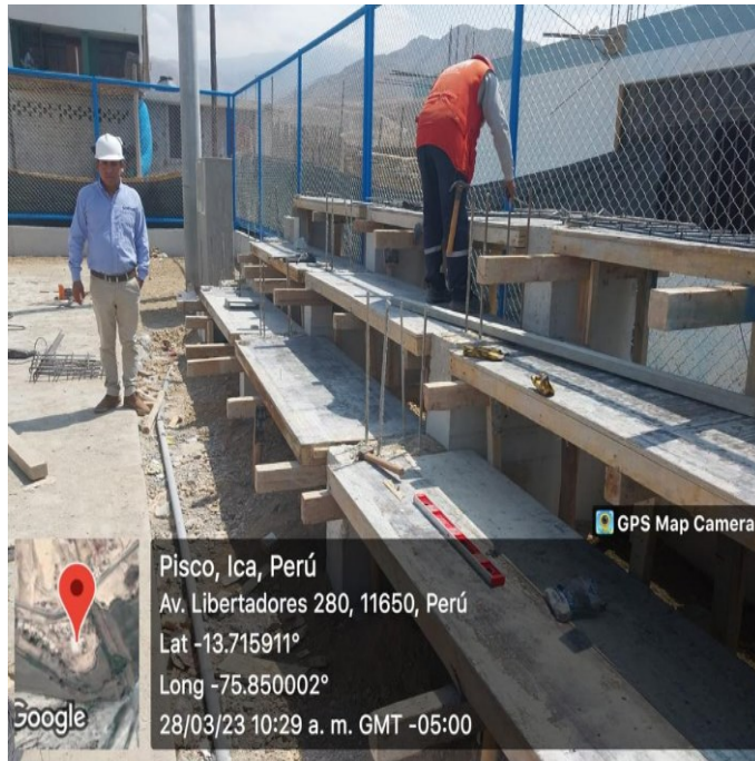
Fig. 70. Vista del encofrado de los descansos
