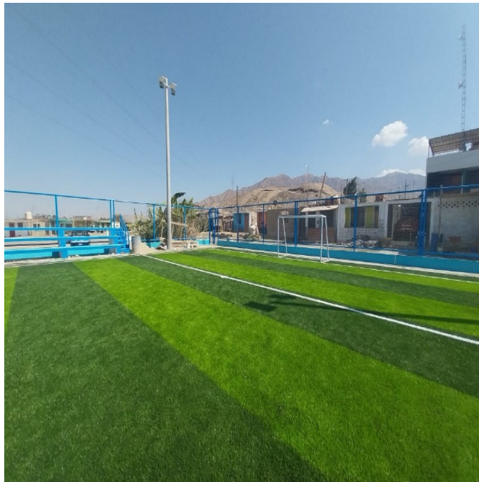
Fig. 85. Vista de la obra entregada
