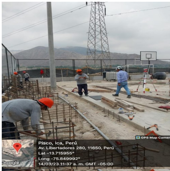
Fig. 63. Armado de acero de placas de tribunas
