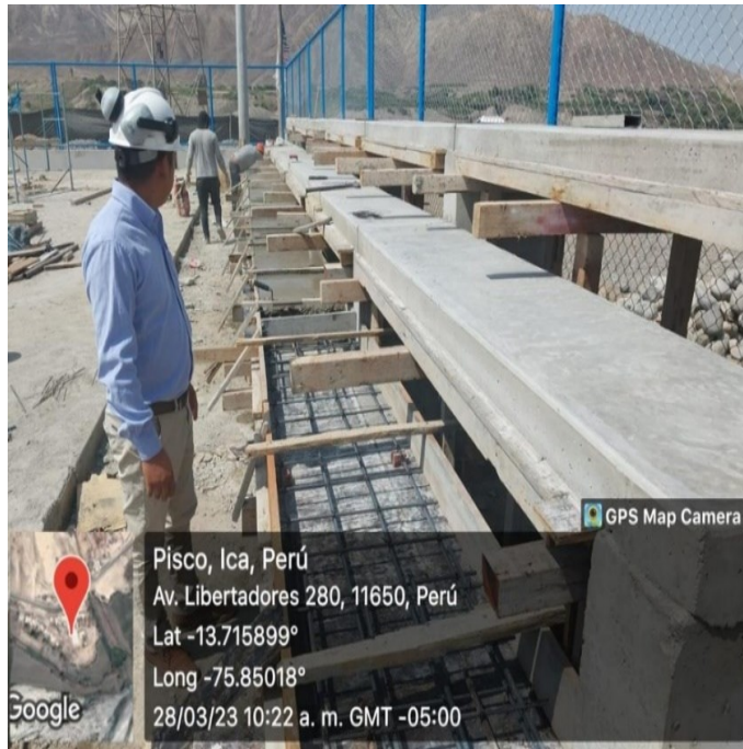
Fig. 72. Vista de la verificación de los paños superiores ya vaciados
