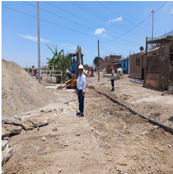
Fig. 41. Verificación de los trabajos de demolición de losa deportiva
