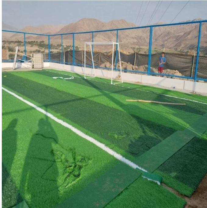
Fig. 79. Vista de la verificación de la cama de arena y grass sintético
