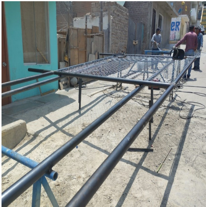
Fig. 51. Se verifica el armado del cerco metálico para proceder a su instalación
