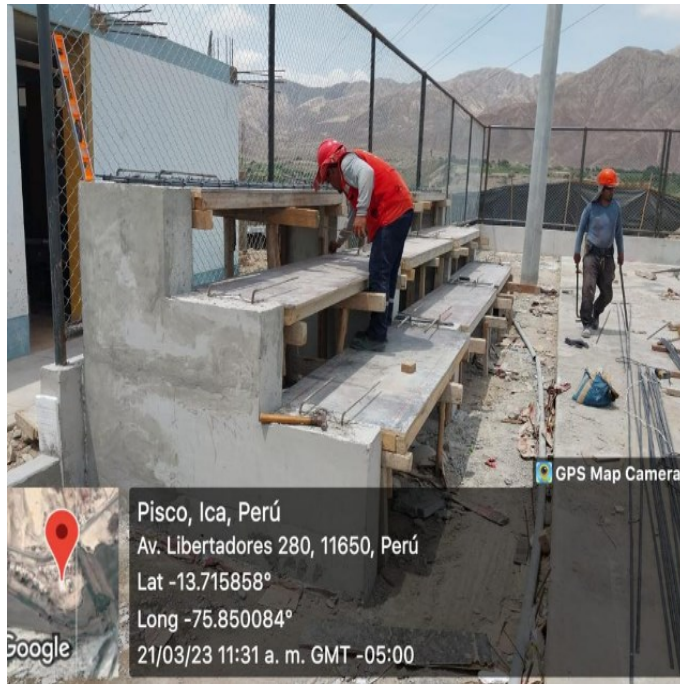
Fig. 68. Vista del encofrado de los descansos
