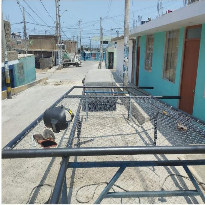
Fig. 50. Se verifica el armado del cerco metálico para proceder a su instalación
