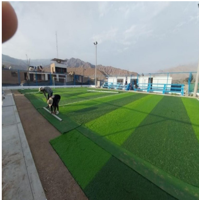
Fig. 80. Vista de la verificación de la cama de arena y grass sintético
