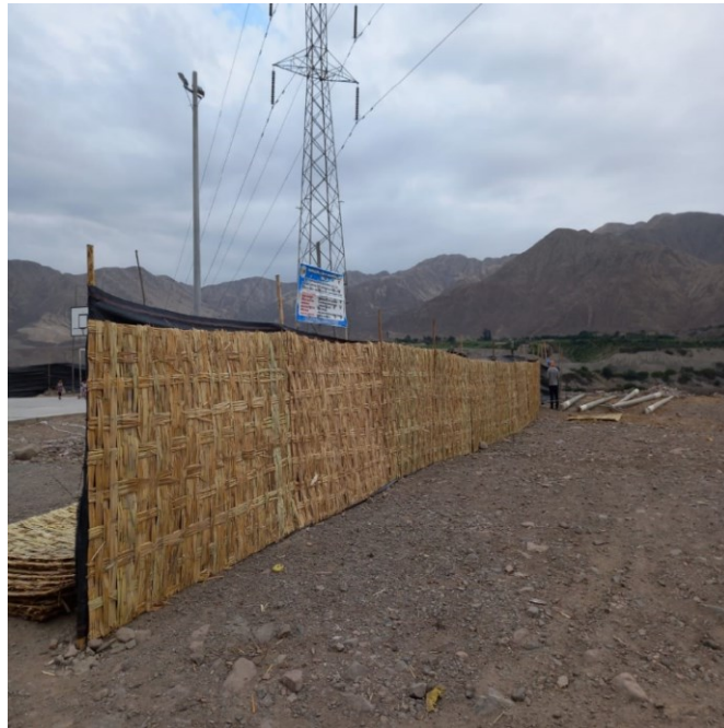
Fig. 13. Vista de la ubicación y colocación del cerco perimétrico
