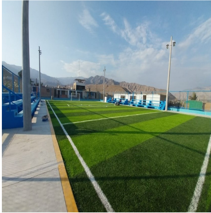
Fig. 84. Vista de la obra entregada
