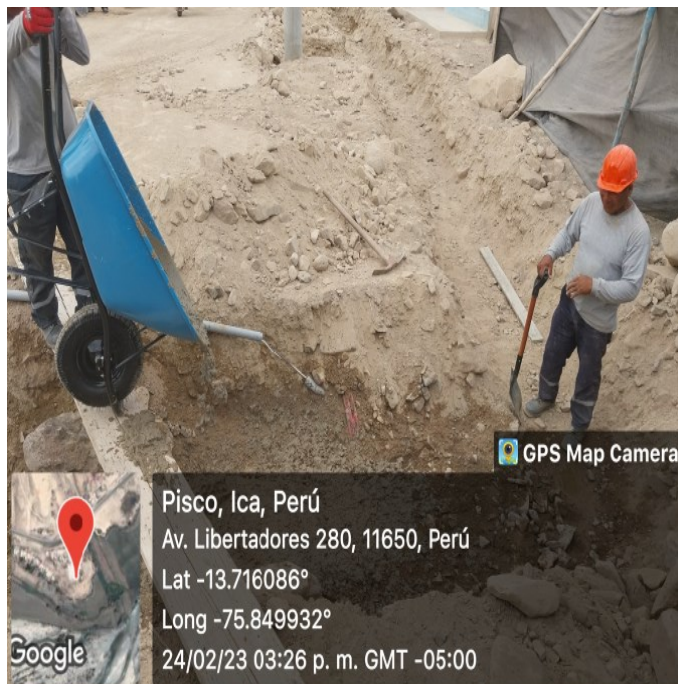
Fig. 38. Vista del vaciado de las zonas de estructuras proyectadas (cimiento corrido)
