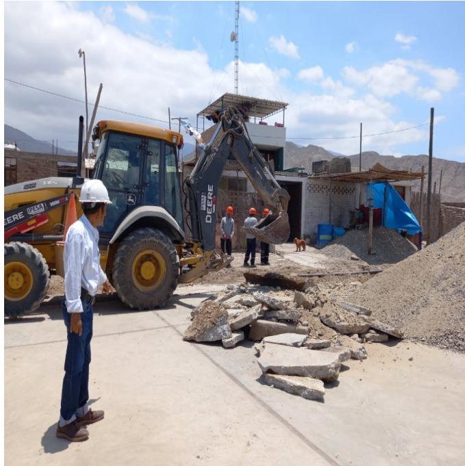
Fig. 40. Verificación de los trabajos de demolición de losa deportiva
