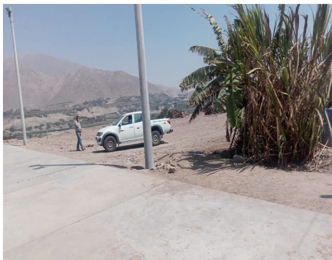
Fig. 3. Estado previo a intervención de losa deportiva ubicada en el centro poblado Pallasca
