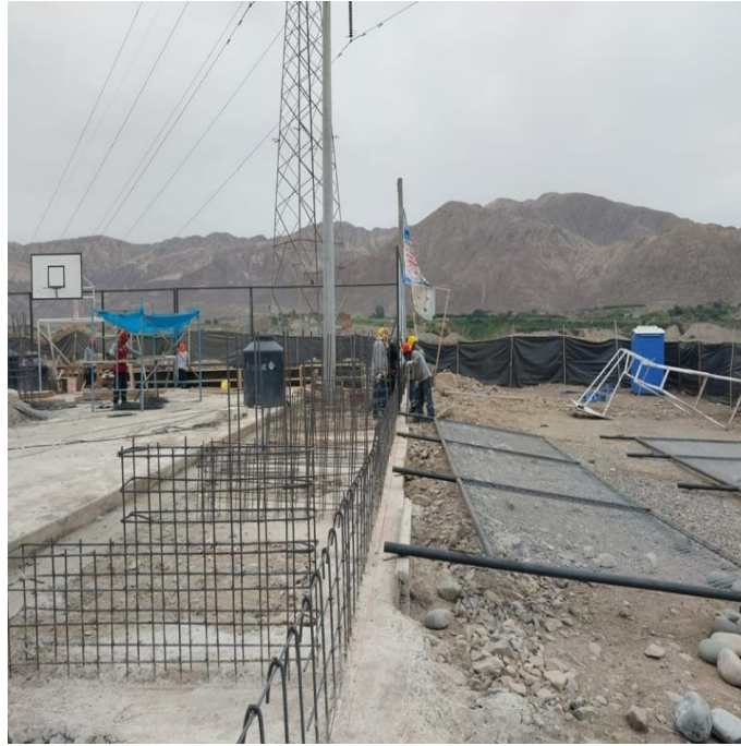
Fig. 52. Isaje y colocación de mallas metálicas
