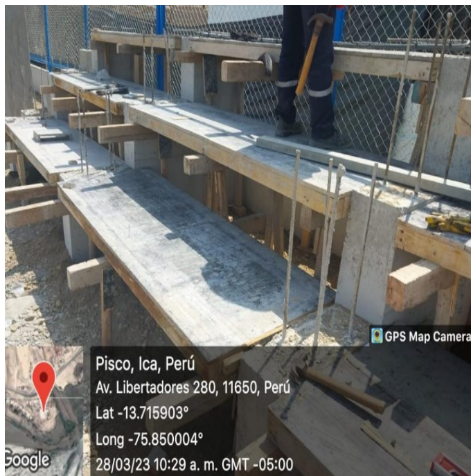
Fig. 69. Vista del encofrado de los descansos
