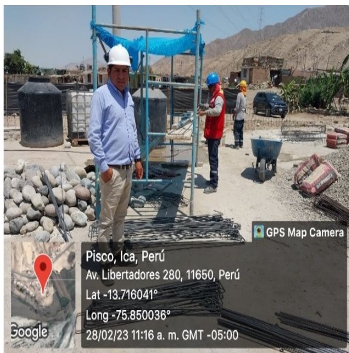
Fig. 32. Vista de la verificación del armado del acero para estructuras proyectadas
