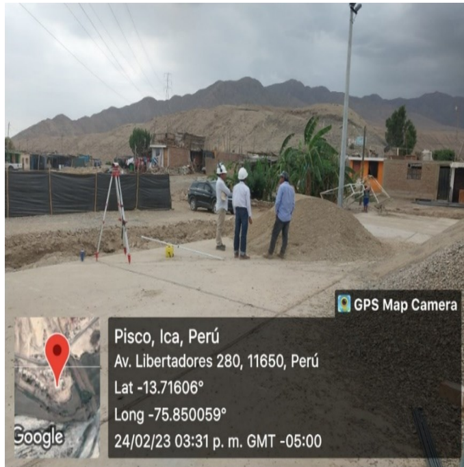
Fig. 25. Vista de la verificación de las zonas de excavación para área de tribunas
