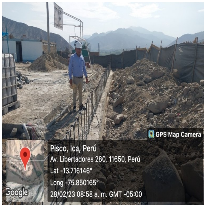
Fig. 43. Verificación de los trabajos de sobrecimiento reforzado-sector 2
