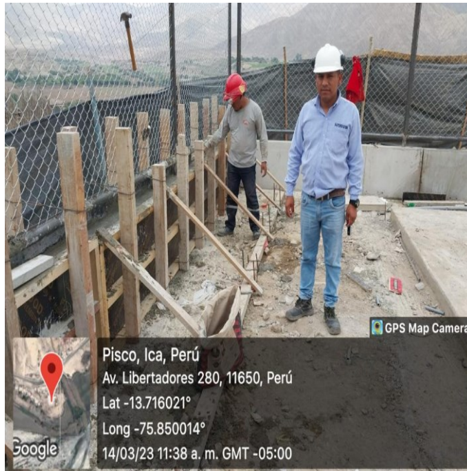
Fig. 56. Verificación del vaciado correspondiente al sobrecimiento del cerco
