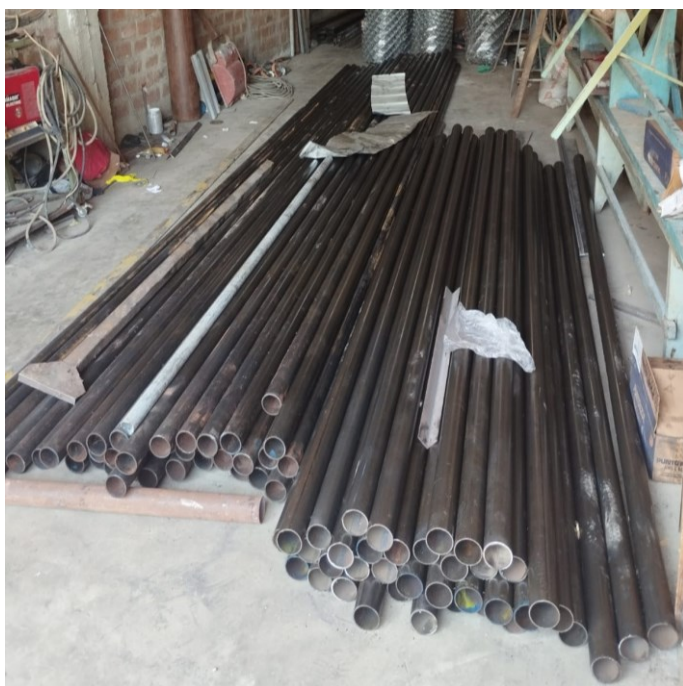
Fig. 49. Se verifica los materiales para la fabricación de cerco de malla metálica
