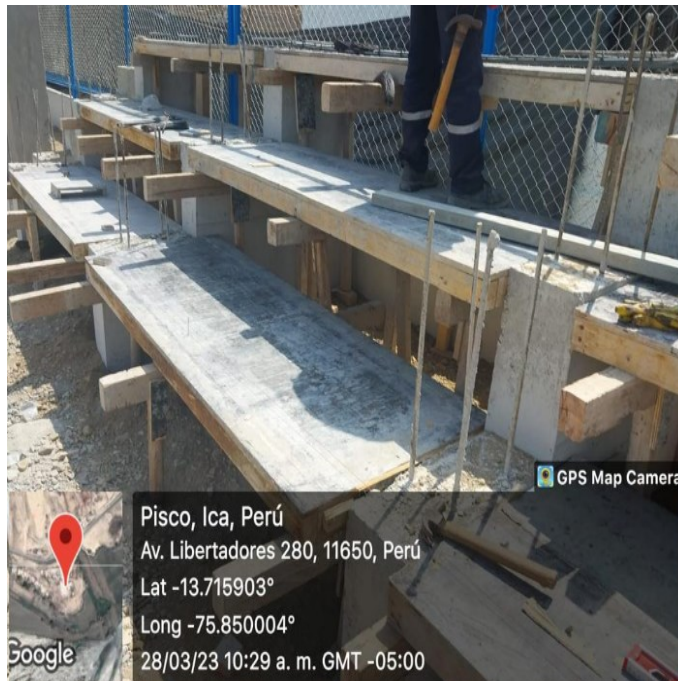
Fig. 67. Vista del encofrado de los descansos
