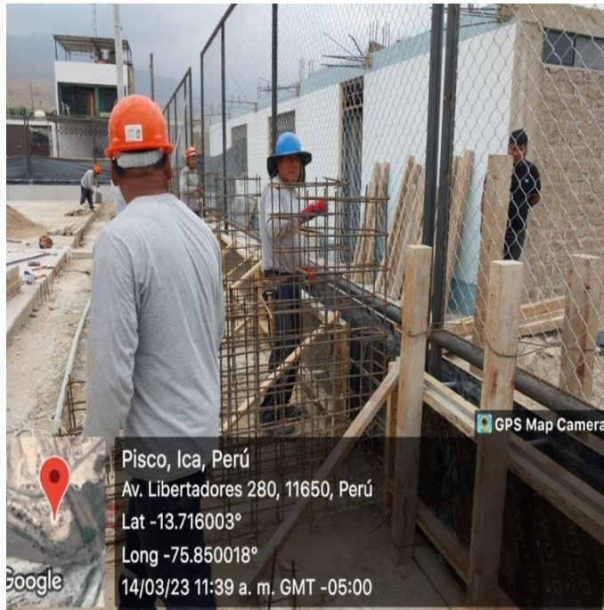
Fig. 60. Armado de acero de placas de tribunas
