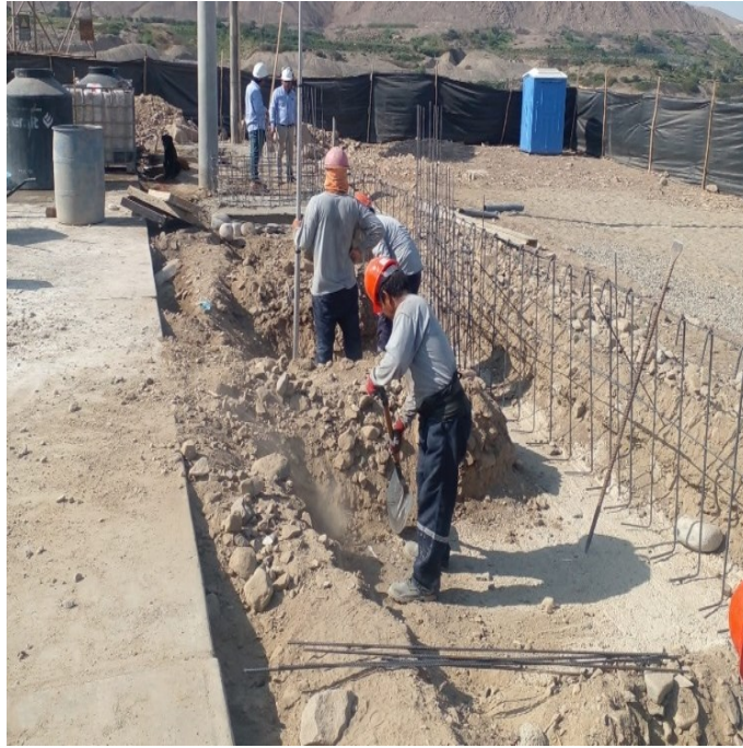
Fig. 42. Verificación de los trabajos de sobrecimiento reforzado-sector 1
