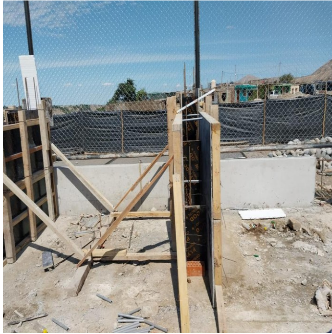
Fig. 64. Verificación del encofrado de las placas
