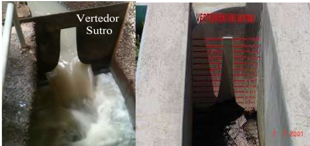
Fig. 12: Vertedero proporcional Sutro
