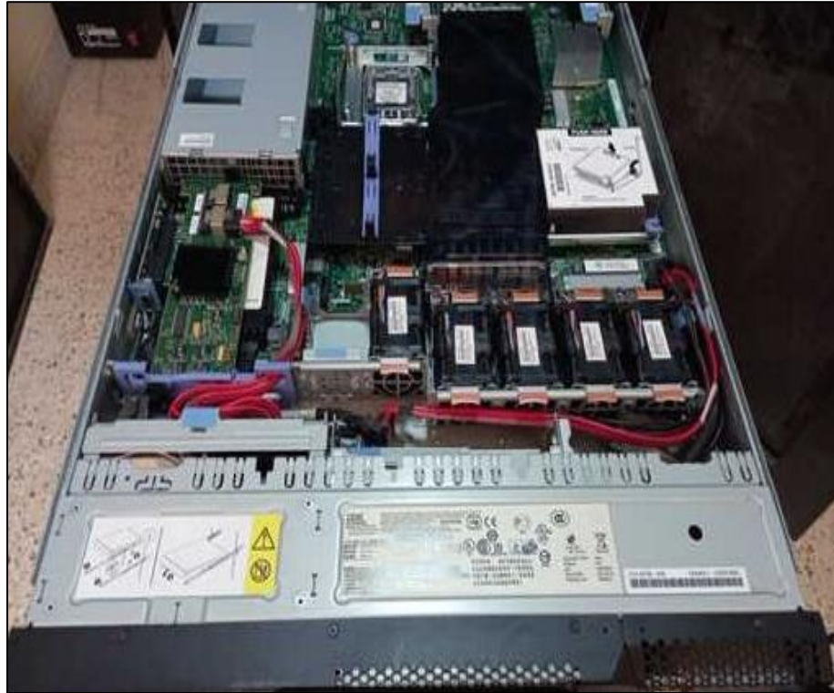
Fig. 6. Mantenimiento al servidor N°1 del data center
