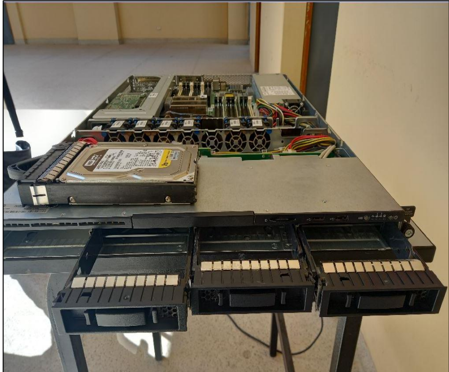
Fig. 8. Mantenimiento al servidor N°3 del data center
