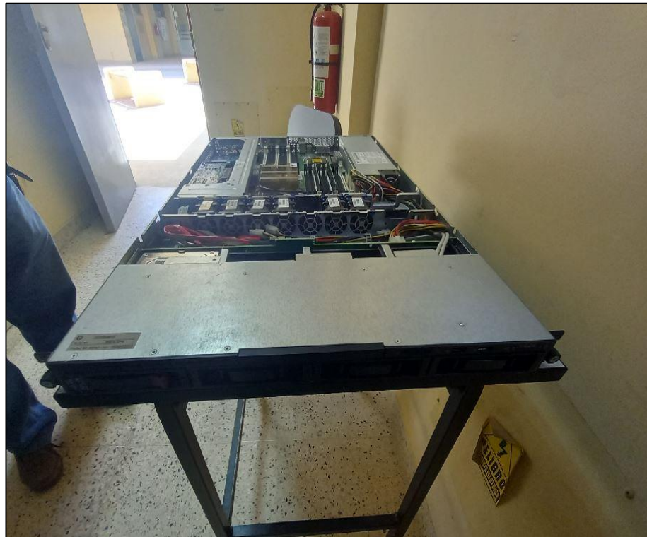
Fig. 9. Mantenimiento al servidor N°4 del data center
