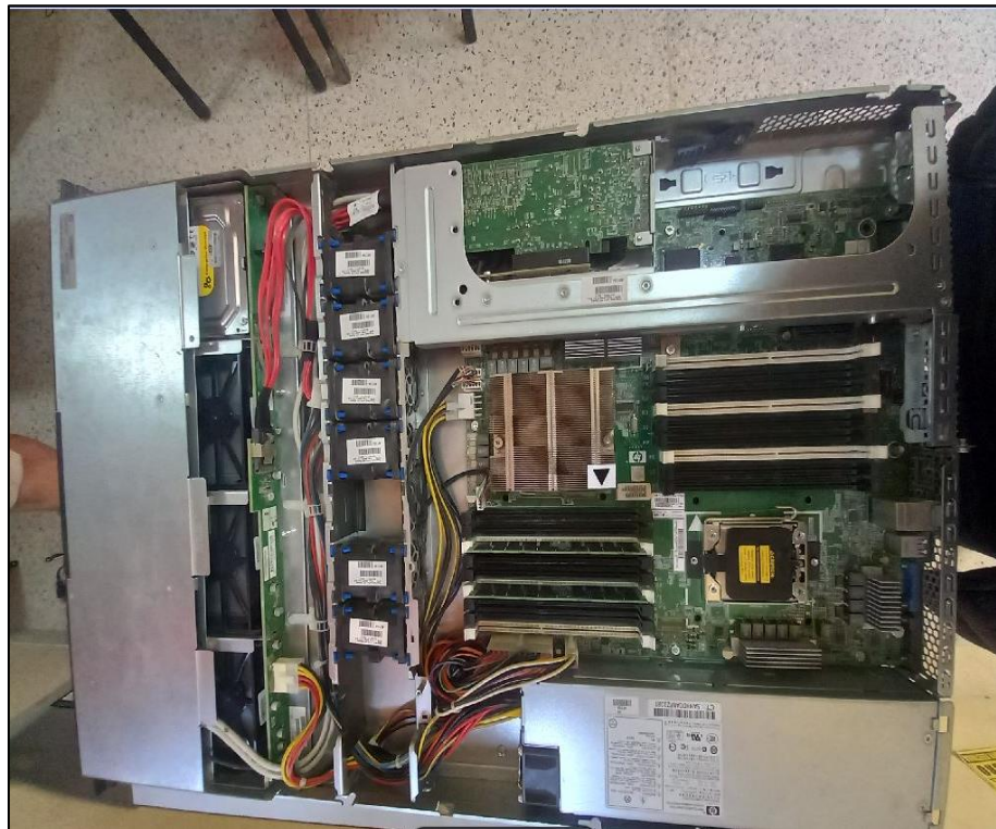
Fig. 7. Mantenimiento al servidor N°2 del data center
