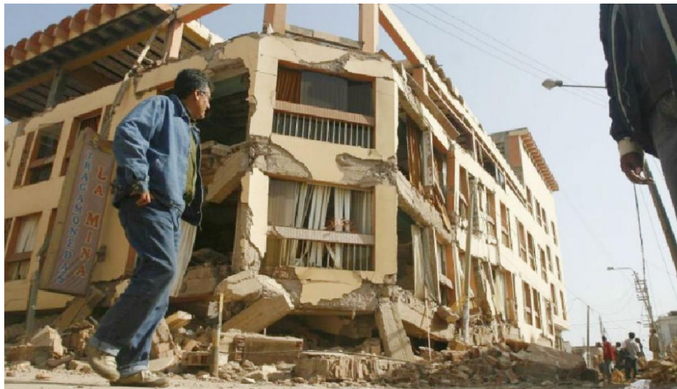
HOTEL COLAPSADO LUEGO DEL SISMO DE 15 DE AGOSTO
