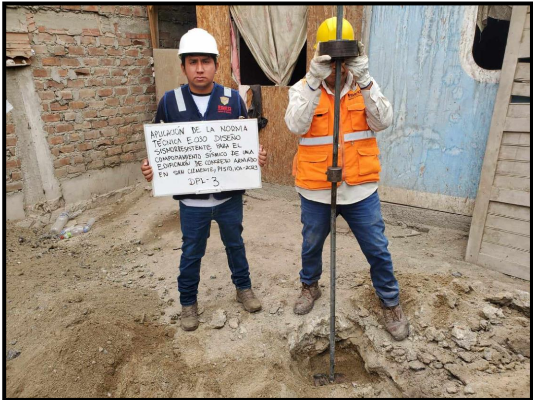
Figura 100. Ensayo de penetración dinámica ligera (DPL-03). Fuente: Creado por el autor.
