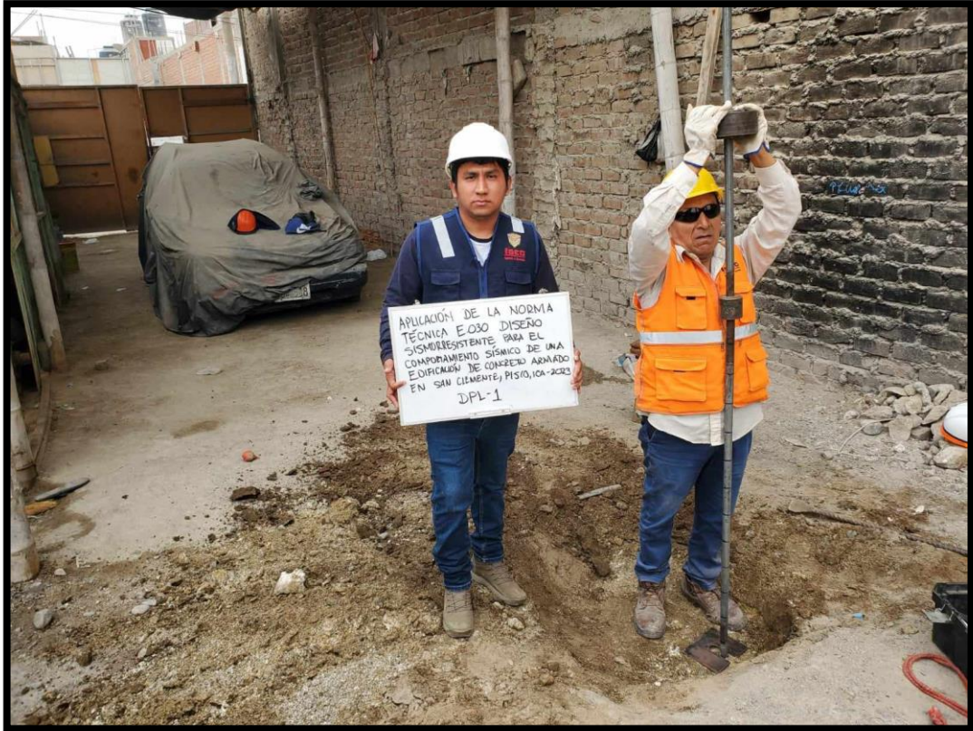
Figura 98. Ensayo de penetración dinámica ligera (DPL-01). Fuente: Creado por el autor.
