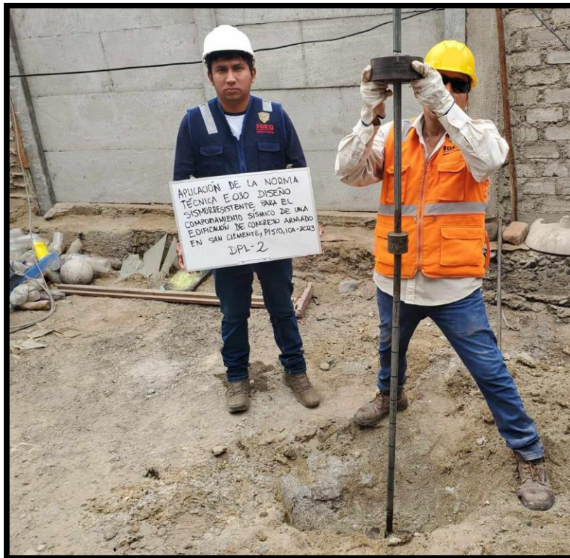
Figura 99. Ensayo de penetración dinámica ligera (DPL-02). Fuente: Creado por el autor.
