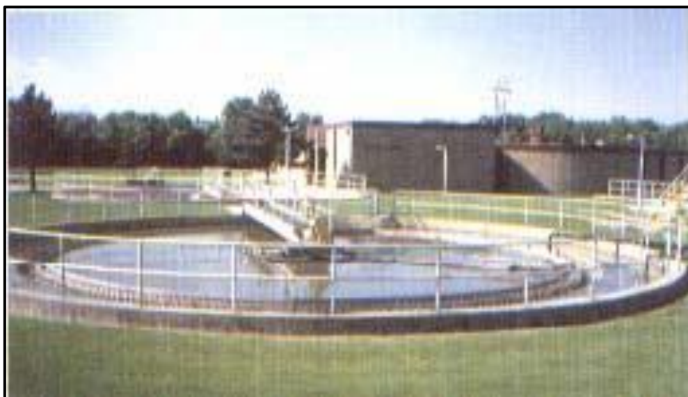
Fig. 4: Planta de tratamiento de aguas residuales
