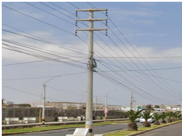
Fig. 1 Foto de Estructura de Alineamiento Típico
