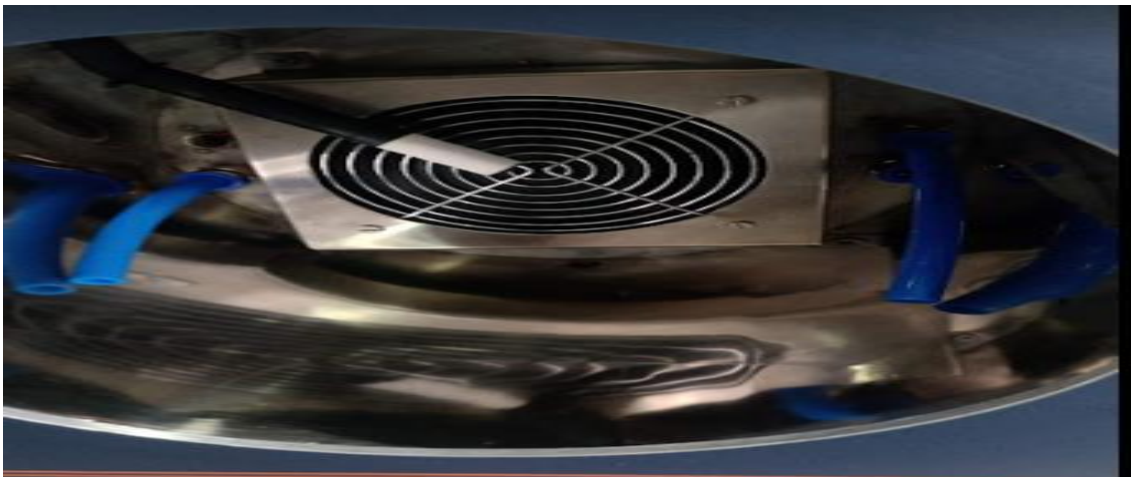
Figura 29. Ubicación del Transmisor de Temperatura y Humedad. Fuente: Elaboración Propia
