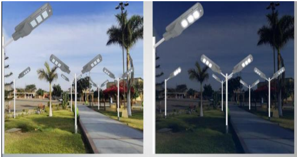
Fig.5 flujo luminoso en la plaza de armas 120 luminarias
