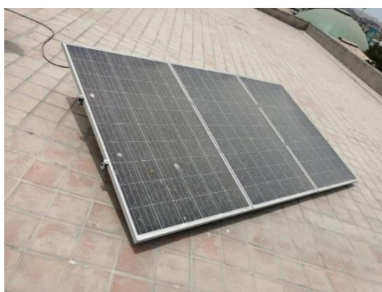
Figura 2. Fotografía de la ubicación de los paneles fotovoltaicos
