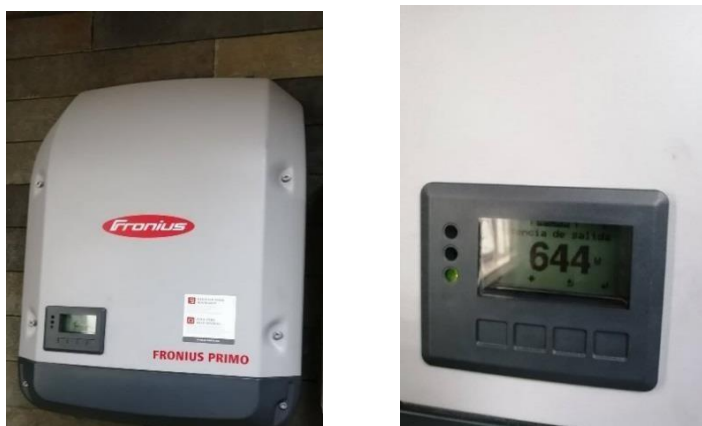
Figura 4. Fotografía del inversor Fronius.
