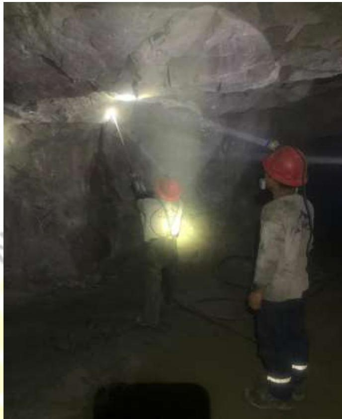
Fotografía 5: perforación de chimeneas.
