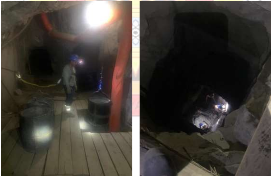
Fotografía 6: Limpieza de piques.
