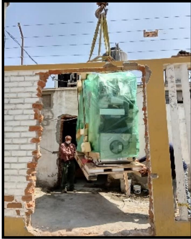
Fig. 44. Traslado del gantry (3/3)
