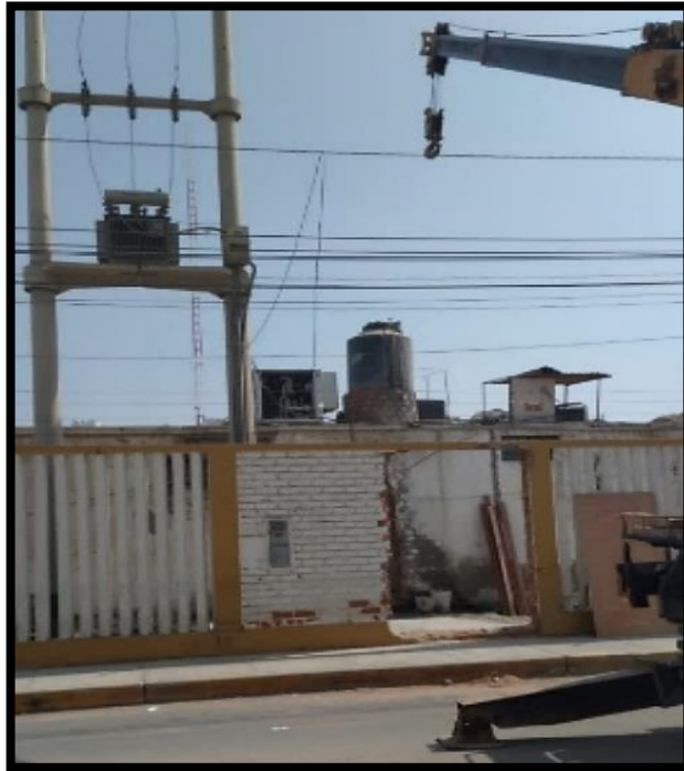
Fig. 40. Demolición de pared para trasladar el tomógrafo.
