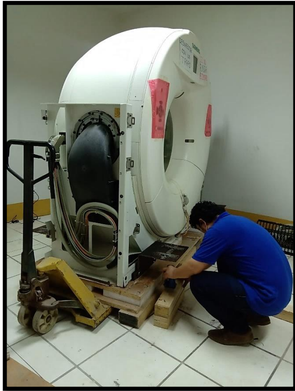
Fig. 67. Anclaje de la unidad gantry
