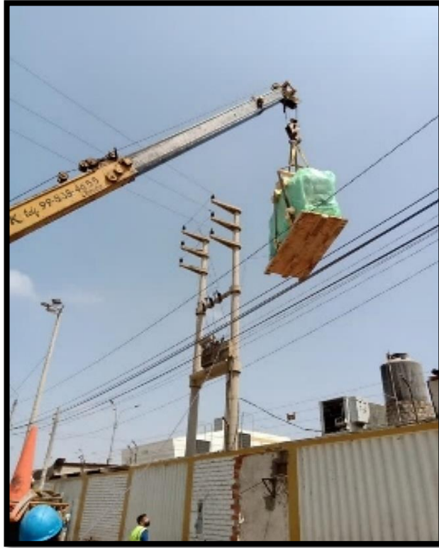
Fig. 42. Traslado del gantry (1/3).
