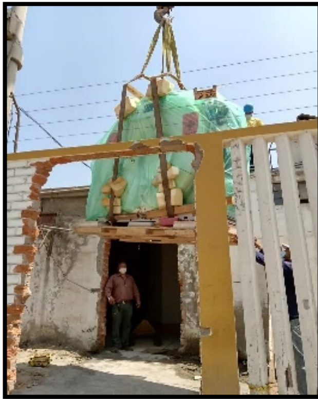
Fig. 43. Traslado del gantry (2/3).
