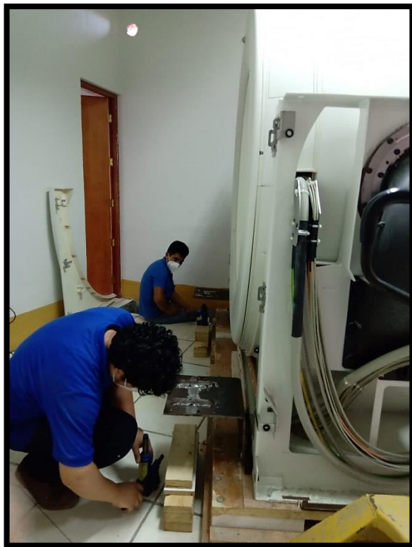
Fig. 68. Nivelación de la sala de procedimientos
