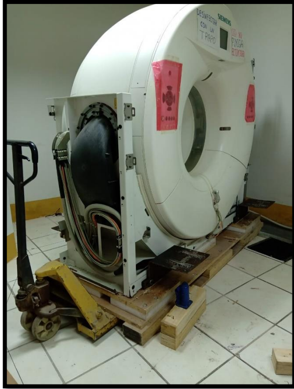
Fig. 69. Nivelación de la unidad gantry
