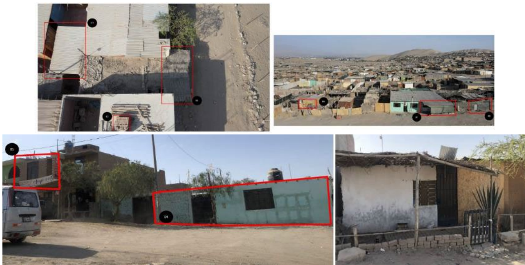
Figura 97: Identificación de materiales Tierra Prometida. Fotografías de visita de campo
