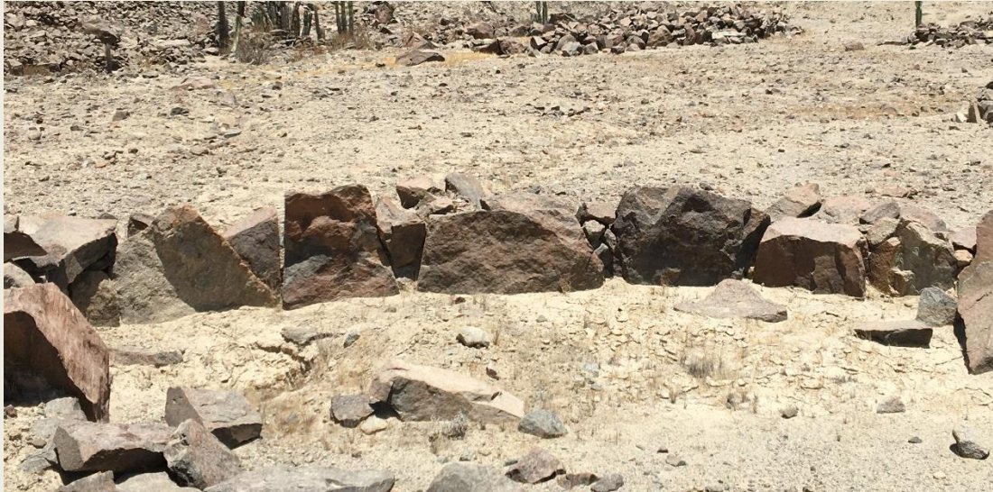
Imagen 57: Vista de noreste a suroeste de la estructura R69, nótese las piedras angulosas y otras semicanteadas, estas últimas dispuestas a modo de “relleno”.
