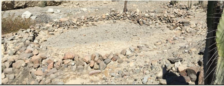
Imagen 3: Vista de sureste a noroeste, paramento interno del muro noroeste del R3.
