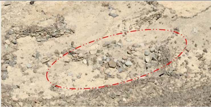
Imagen 09: Vista elevada de este a oeste de estructura R17, nótese el colapso de sus muros.
