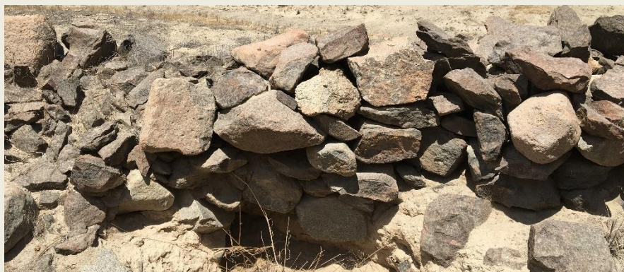
Figura 67: Nótese la segunda técnica de construcción de muros predominando el uso de piedras semicanteadas.
