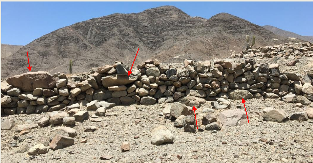
Imagen 39: Vista de este a oeste del muro de contención (¿?), flechas indican la presencia de piedras grandes, medianas y pequeñas como parte del paramento.
