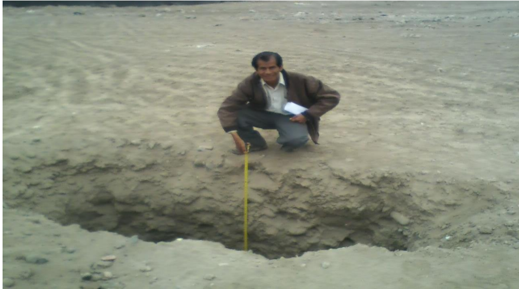
Fig. 19. Vista exploración de estudios de suelos de habitación urbana
