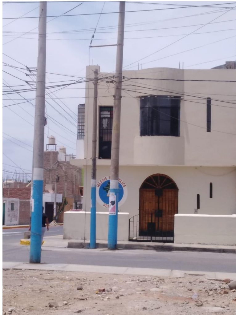
Fig. 75: Vista fachada frente
