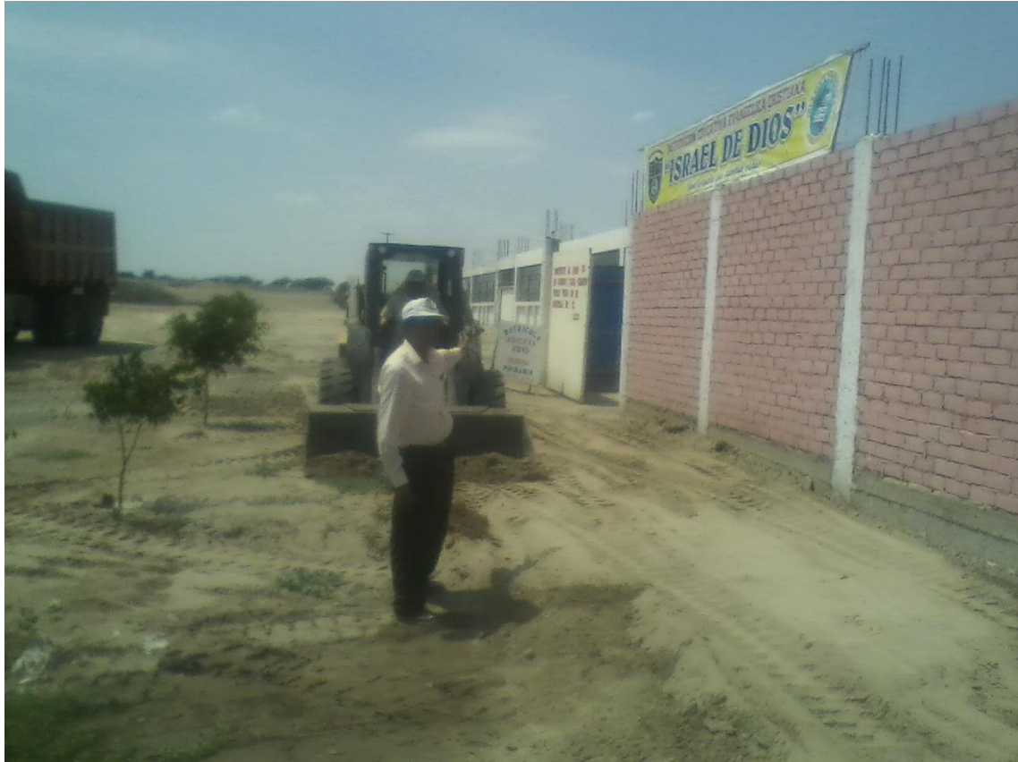
Fig. 18. Vista de trabajos IEP Israel de Dios
