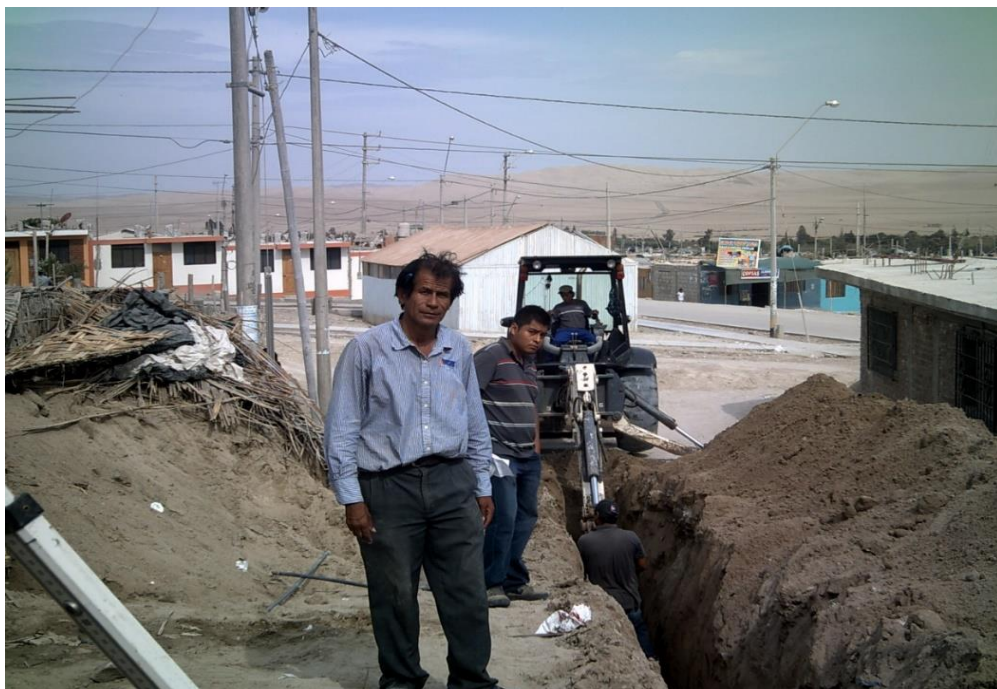
Fig. 12. Vista ejecución de redes de alcantarillado
