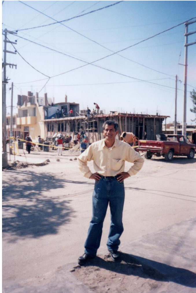
Fig. 73 Vista de ejecución de obra del proyecto
