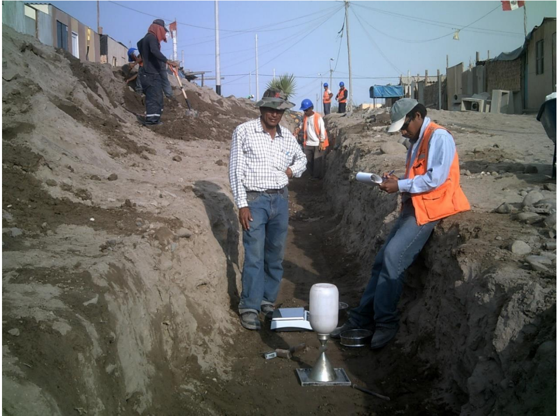
Fig. 15. Vista de trabajos geotécnicos en redes hidráulicas
