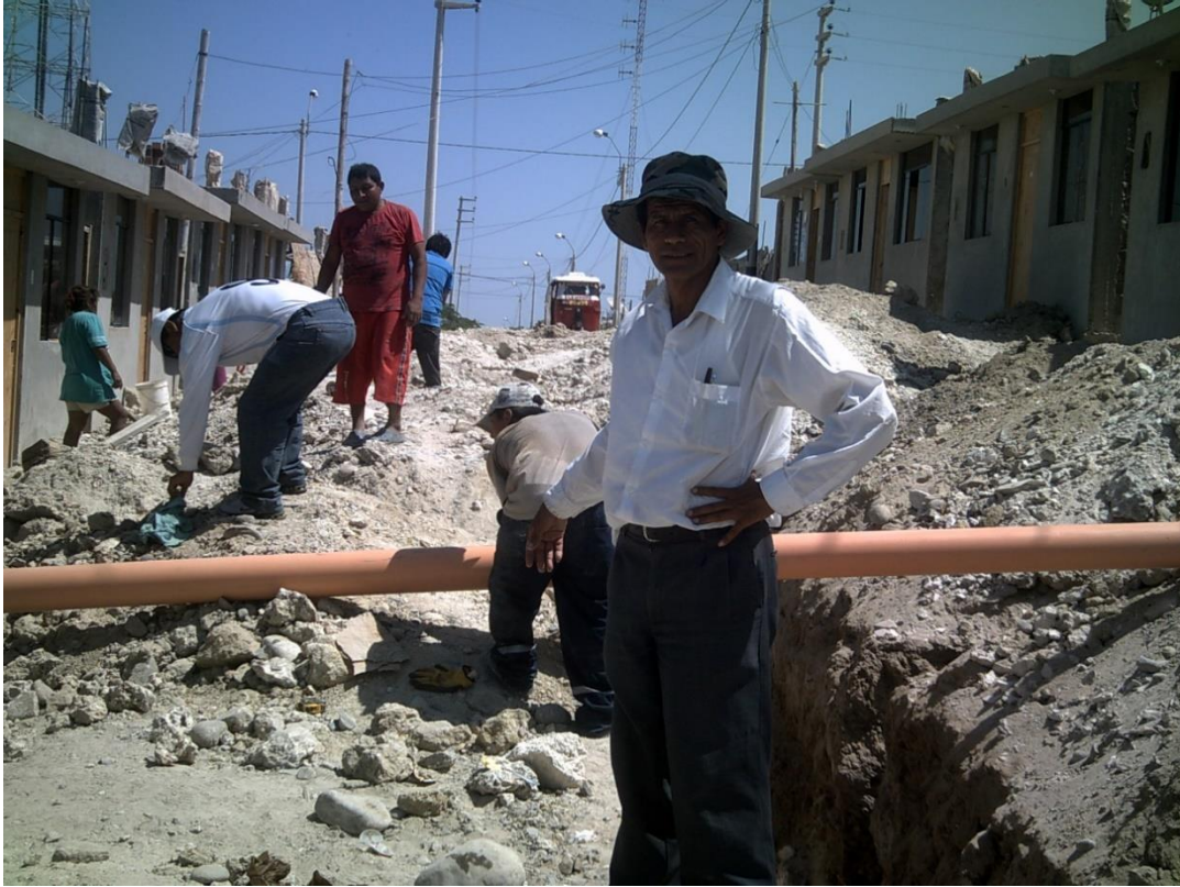
Fig. 13. Vista de trabajos de alcantarillado
