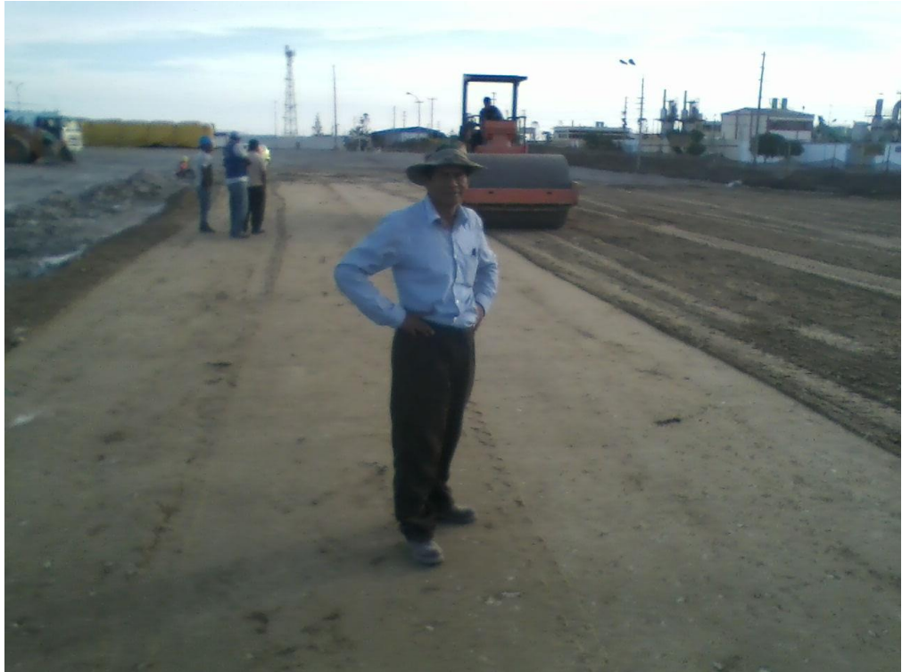
Fig. 16. Vista de ejecución de pistas viales
