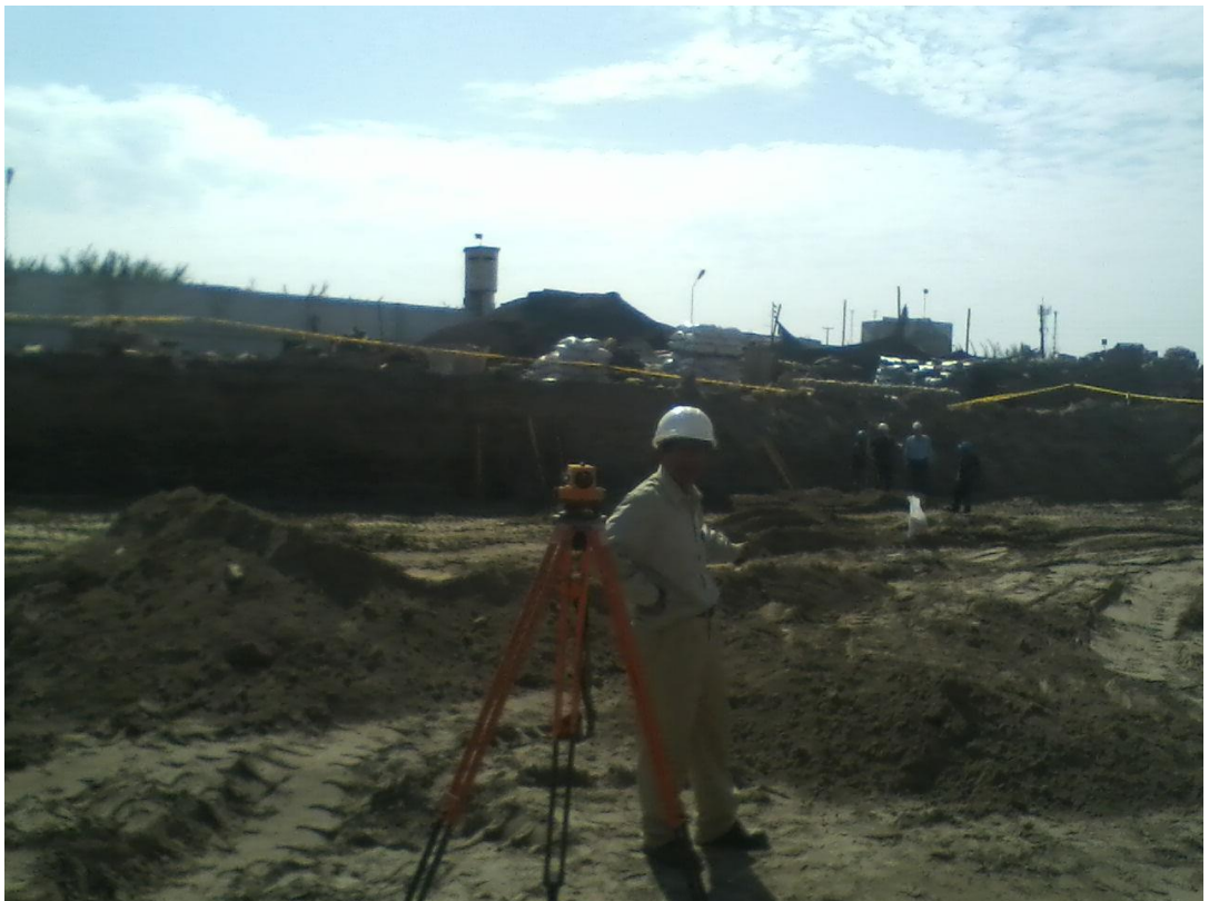
Fig. 17. Vista de trabajos de replanteo
