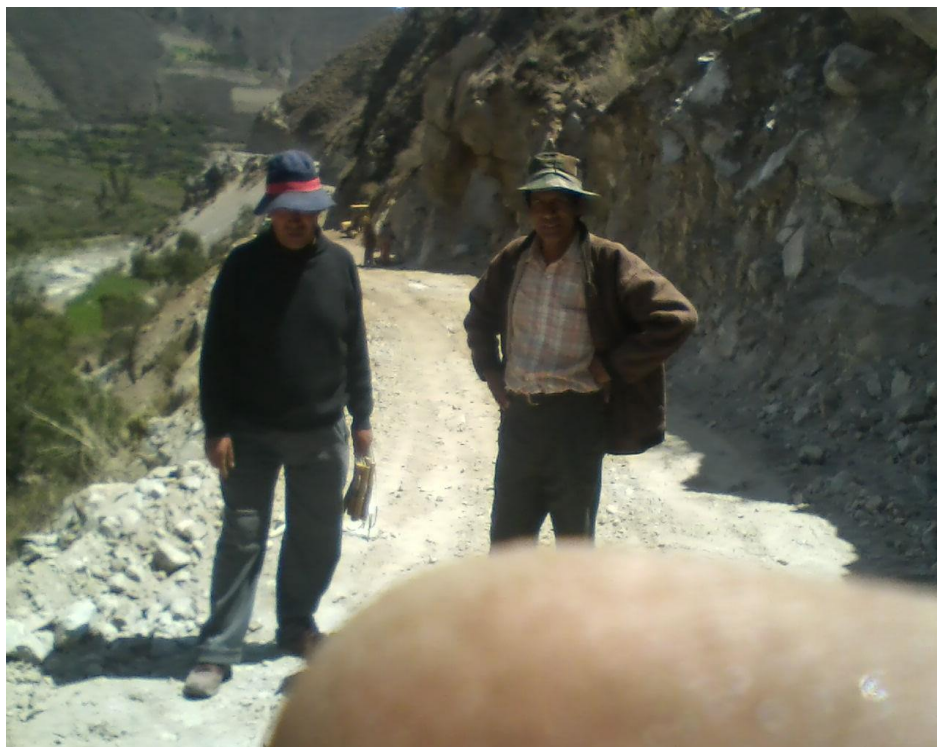
Fig. 8. Vista de construcción de carreteras
