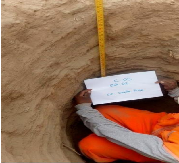
Fig. 15. Calicata N 05 – ESTr 02
