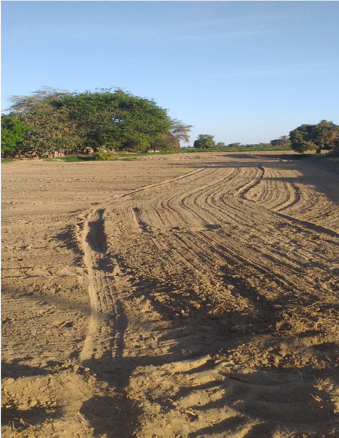
Fotografía 2: arado y planchado del terreno
