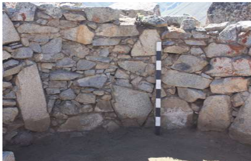
Foto N° 01: Vista general de la unidad arquitectónica N° 07. Del perfil interno lado sur.
