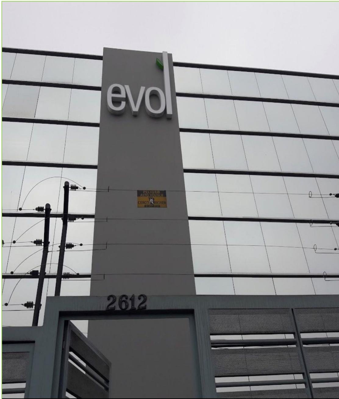
Fig. 28: Dirección del edificio de la empresa EVOL (TS NET S.A.)
