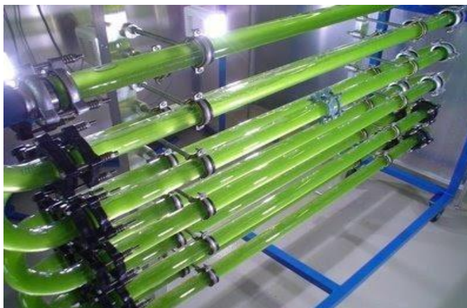
Ilustración 8 Photobioreactor de biocombustible
