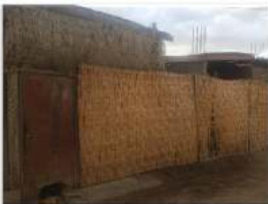
Foto 8. Vivienda de estera en estado regular.
