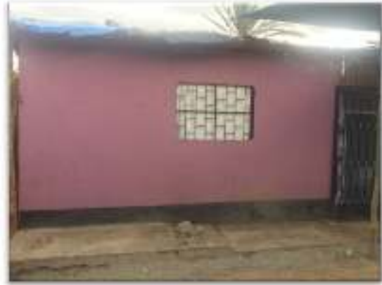
Foto 6. Se aprecia vivienda de madera prensada, con cobertura de material rustico.
