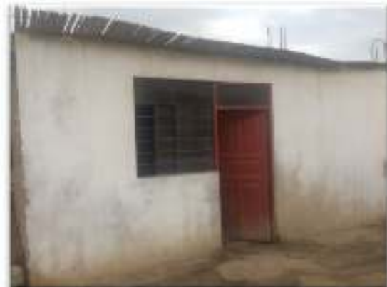
Foto 9. Vivienda de albañilería con cobertura de caña y torta de barro.
