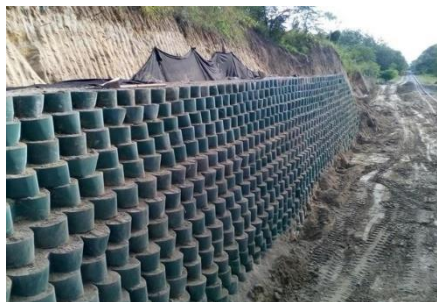
Fotografía 5.9. Muro de tierra reforzada con geoceldas
