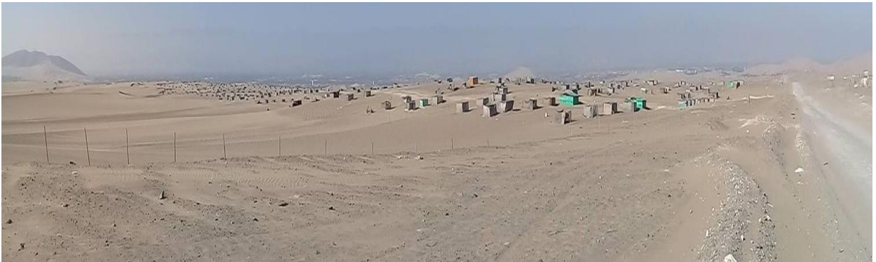
Figura N° 12. Vista panorámica del Programa Municipal Vivienda Digna en el Km7 de la carretera a Carhuas, lugar en donde se ubicará el proyecto de mercado mayorista. A la derecha de la imagen se encuentra la vía Comatrana-Carhuas. Al fondo de la imagen, al lado izquierdo se ubicará el proyecto.
