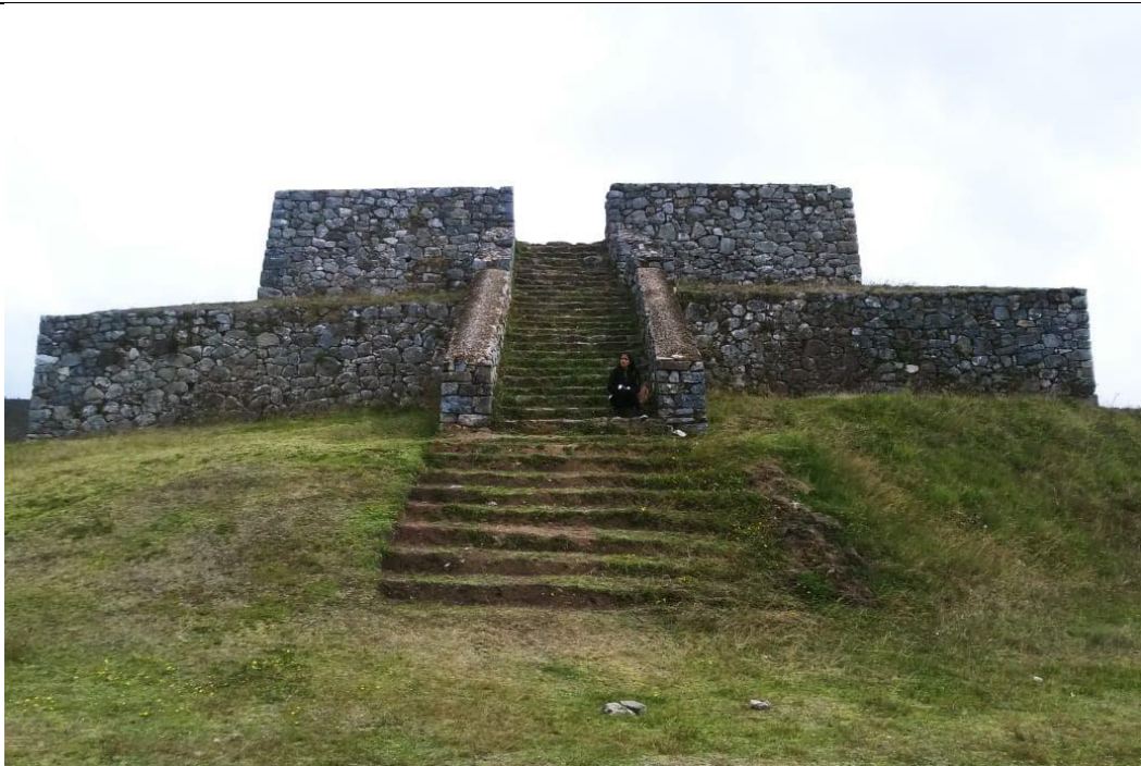
Vista del vano de acceso del Ushnu de Curamba. Yurissa Florez; 2022
