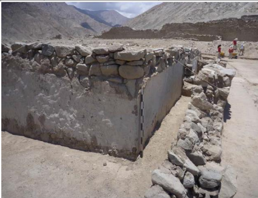
Muros del primer momento constructivo con enlucido de color blanco, y muro de la ampliación de la plataforma, permitiendo la clausura de la escalinata estrecha. Fuente: Alejandro Chu; 2015: 101
