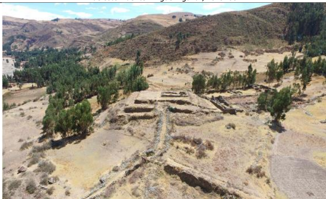
Vista del Ushnu de Choquerecuay y del camino Inca que conduce a la escalinata del mismo. Fuente: Miguel Aguilar; 2019: 16
