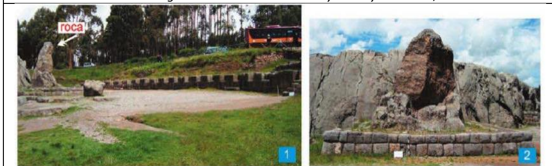
Vista de la plaza semicircular con los muros con nichos y la roca vertical colocada sobre una pequeña plataforma en uno de los laterales de la plaza de Quenqo Grande.
