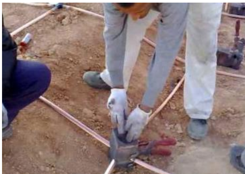
Fig. 25 Malla y red de puesta a tierra.
