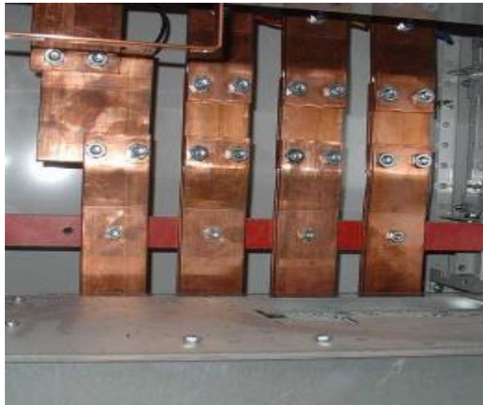
Fig. 21 Barras colectoras
