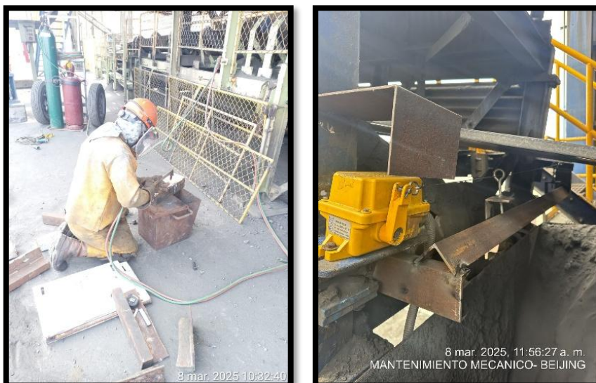
Fig. 18. Fabricación de soporte e instalación de sensor
