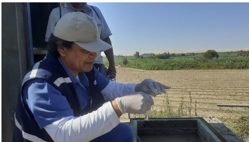
Figura 7. Dosificación de hipoclorito de calcio. Elaboración propia
