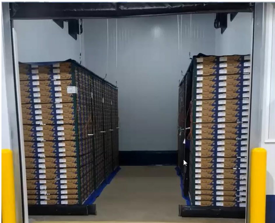
Figura 12. Productos en túneles de enfriamiento
