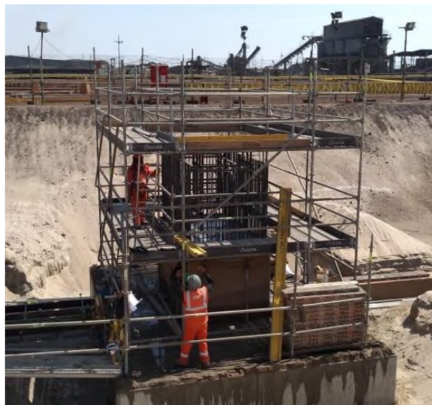
Figura 34. Instalación de acero de segunda altura en pedestal P-2 en Nave de Palanquillas.
