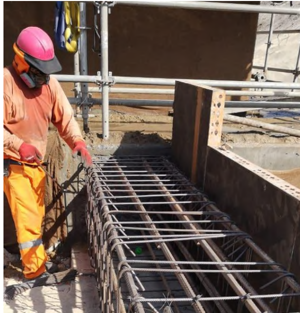
Figura 35. Instalación de acero en viga de conexión VA-2 en Nave de Palanquillas.
