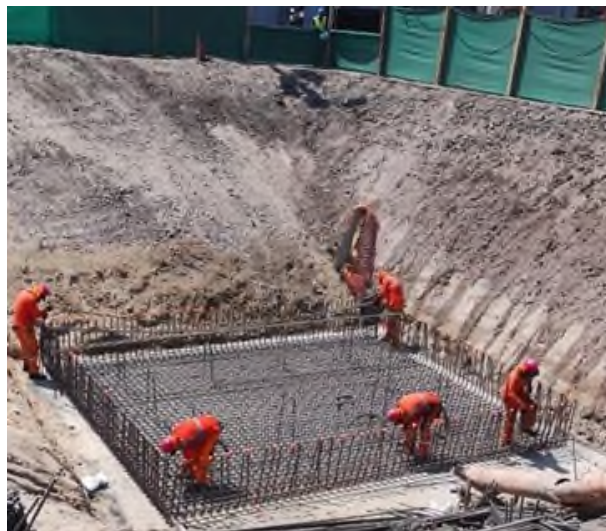
Figura 32. Instalación de acero en zapata tipo Z-2 en Nave de Palanquillas.
