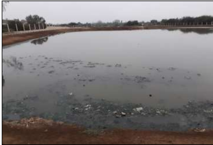
Figura 2. Laguna de oxidación
