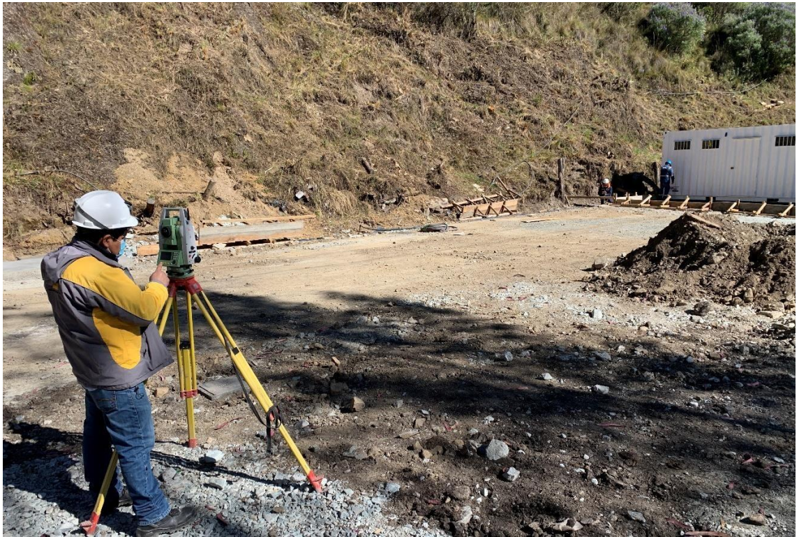
Figura 18. Zona 01 - Sub-Estación (04 Iglús) Trazo y replanteo. Fuente: Elaboración Propia
