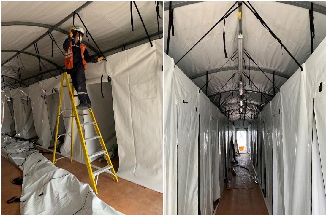
Figura 27. Zona 03 - Chilcas Oeste (05 Iglús) Montaje interno de estructuras, materiales, procura. (Fuente: Elaboración Propia)
