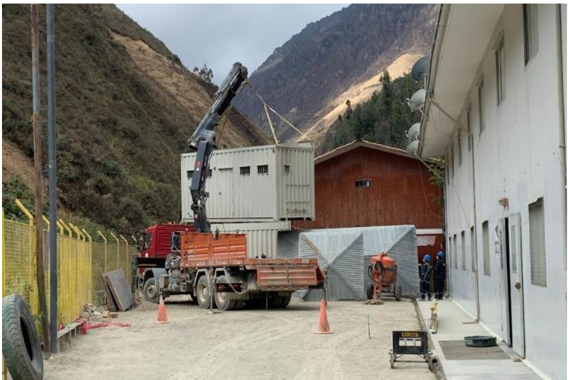
Figura 29. Zona 04 - Chilcas bajo (05 Iglús) Traslado de componentes para montaje. (Fuente: Elaboración Propia)
