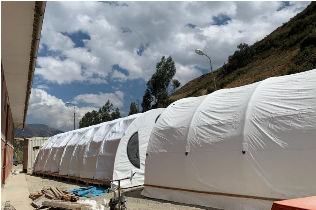
Figura 30. Zona 04 - Chilcas bajo (05 Iglús) Trabajos ejecutados. (Fuente: Elaboración Propia)
