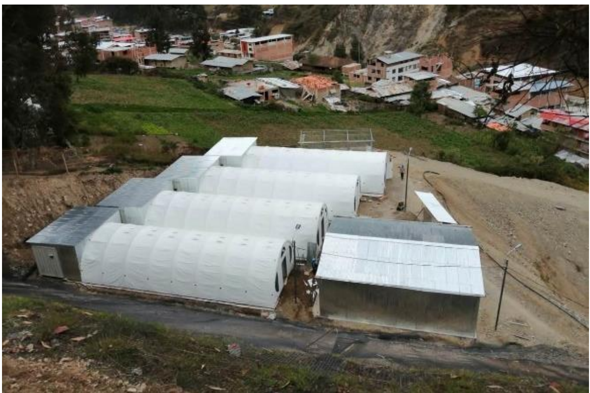
Figura 23. Zona 02 - Casa tapial (10 Iglús) Trabajos ejecutados (04 und). Fuente: Elaboración Propia
