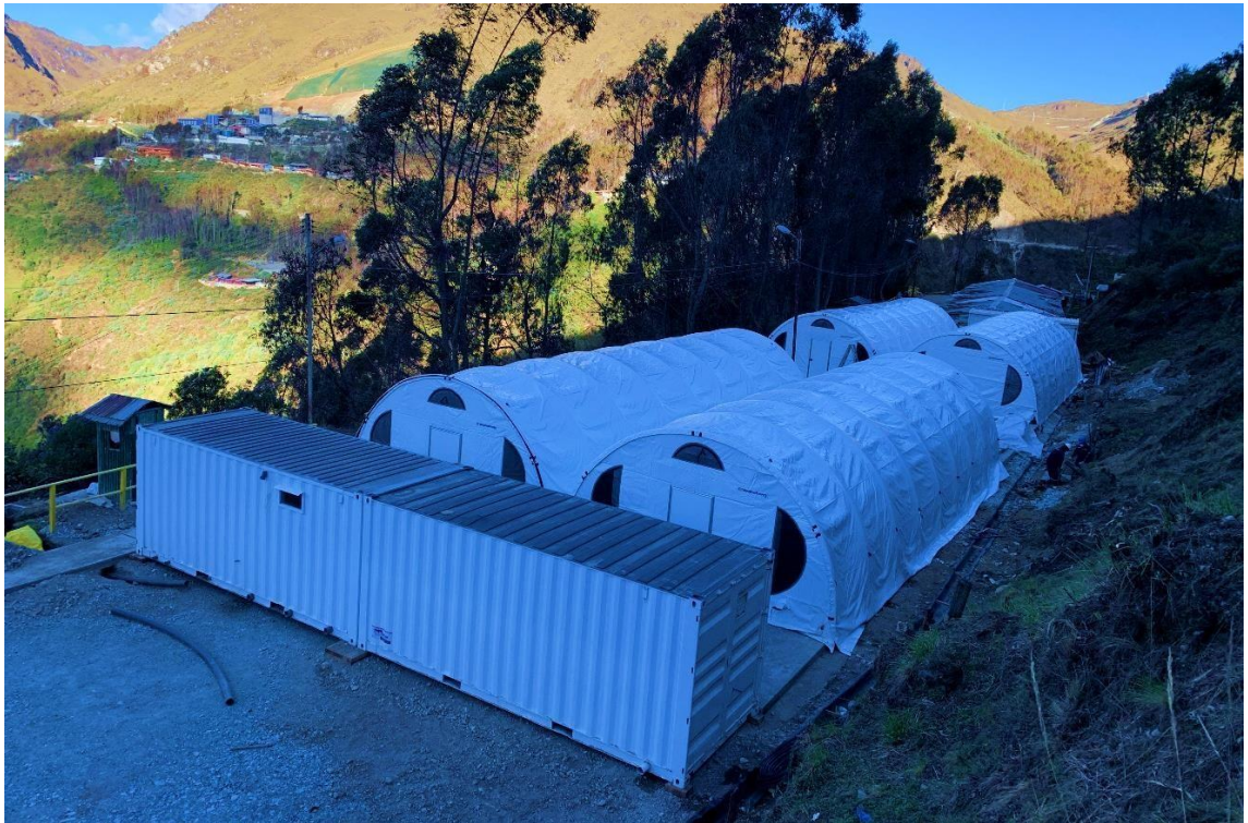
Figura 20. Zona 01 - Sub-Estación (04 Iglús) Trabajos ejecutados. Fuente: Elaboración Propia
