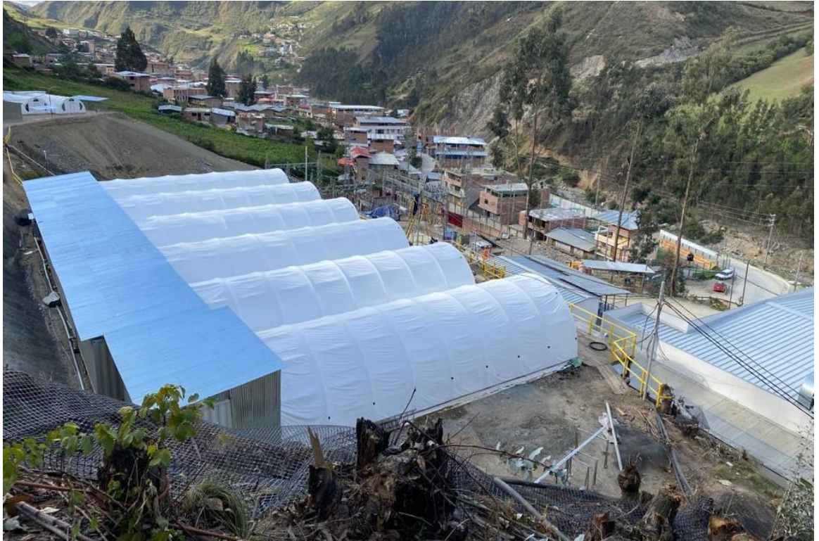
Figura 24. Zona 02 - Casa tapial (10 Iglús) Trabajos ejecutados (06 und). Fuente: Elaboración Propia
