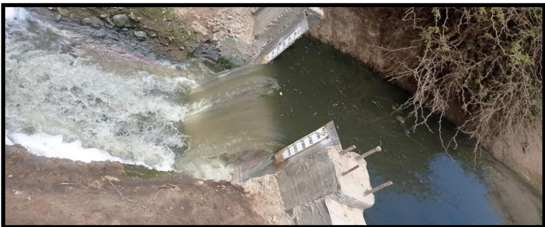
Figura 11: Salida de la laguna facultativa secundaria
