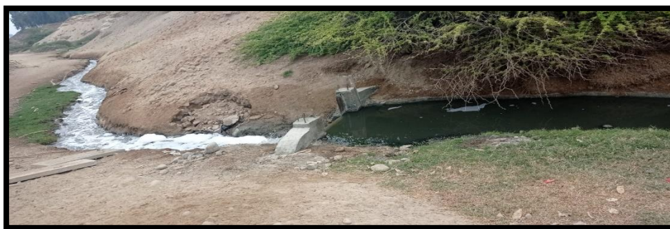
Figura 3. Salida de la Laguna Facultativa “San Francisco”
