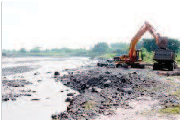
Fig. 12 Extracción de la piedra de río.
