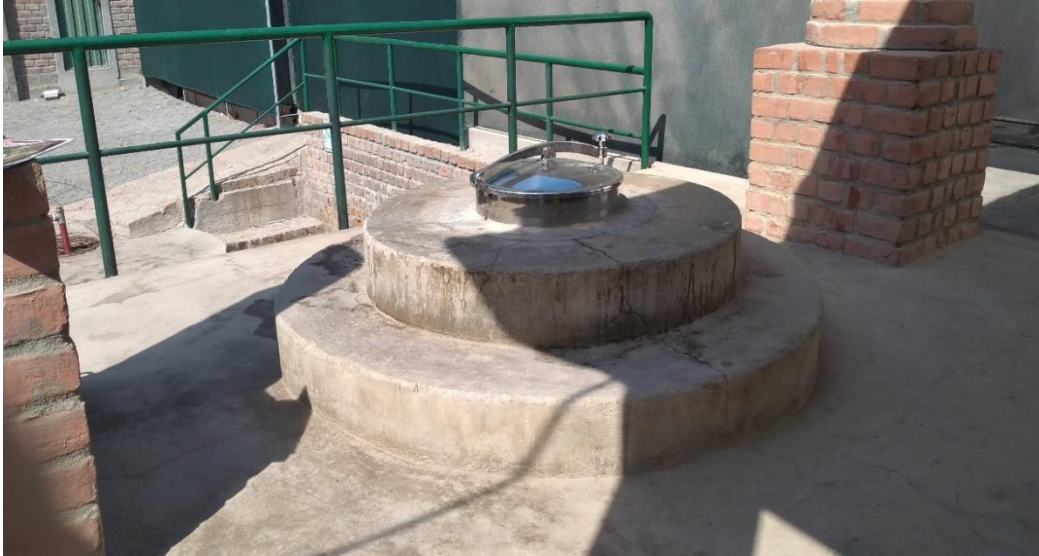
Figura 5.13 Fisura desde el exterior de una paila en funcionamiento.
