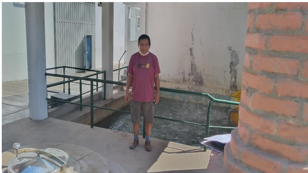
Figura 5.28 Recirculación de agua en alberca.
