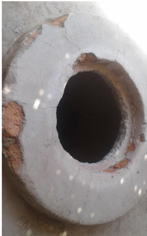
Figura 5.8 Fisuras moderadas.
