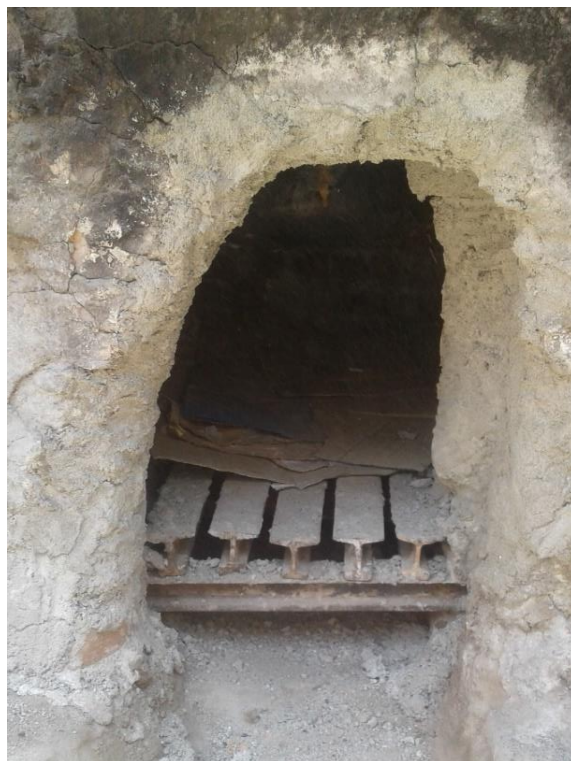
Figura 5.15 Boca del horno sin respiradero
