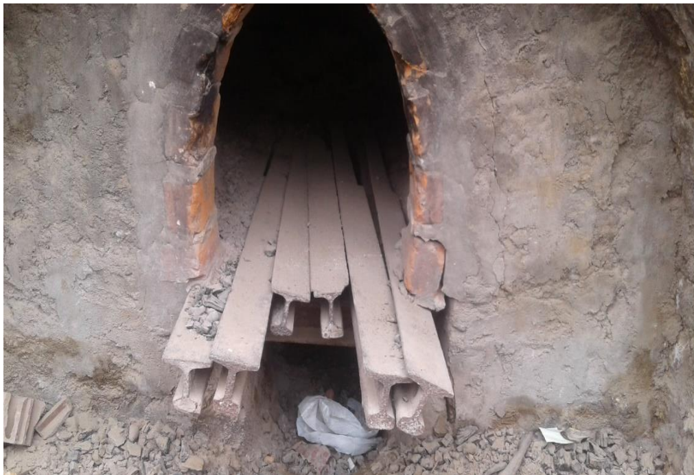
Figura 5.14 Boca del horno con ladrillos y rieles mal colocados.
