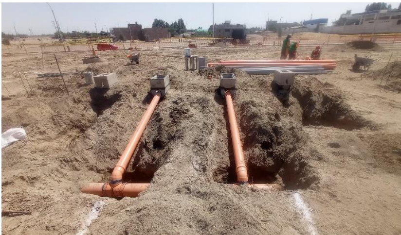
Fotografía 9. Prueba hidráulica en red a zanja abierta proyecto habitacion urbana Posada del Sol - Killari
