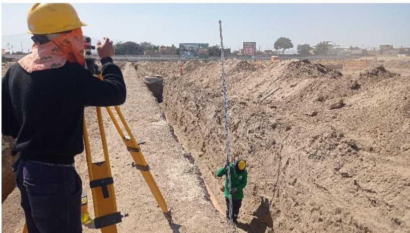
Fotografía 5. Solaqueo de cajas de registro proyecto habitacion urbana Posada del Sol - Killari
