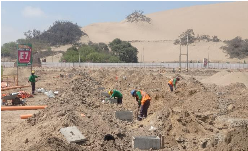
Fotografía 5. Solaqueo de cajas de registro proyecto habitacion urbana Posada del Sol - Killari
