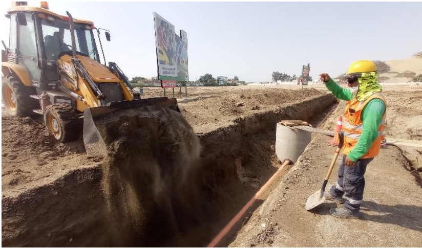
Fotografía 7. Aplicación de relleno con arena proyecto habitacion urbana Posada del Sol - Killari
