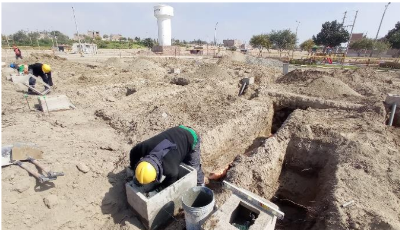
Fotografía 6. Nivelación de tubería proyecto habitacion urbana Posada del Sol - Killari
