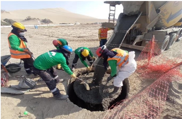
Fotografía 2. Vaciado de buzones proyecto habilitacion urbana Posada del Sol - Killari
