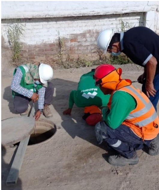
Fotografía 11.. Prueba de estanqueidad proyecto habitacion urbana Posada del Sol - Killari
