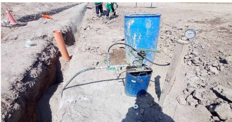
Fotografía 9. Prueba hidráulica en red a zanja abierta proyecto habitacion urbana Posada del Sol - Killari
