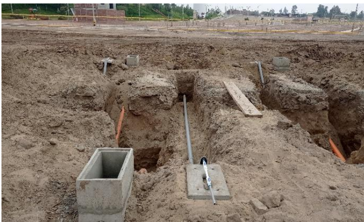
Fotografía 3. Colocación de cajas de registro proyecto habilitacion urbana Posada del Sol - Killari
