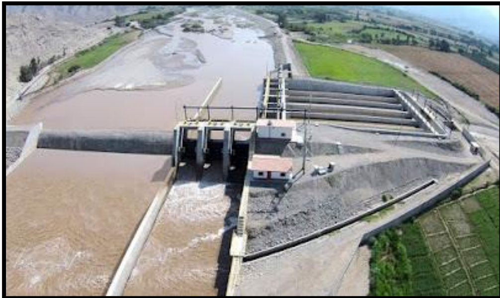
Nota. Otra vista de La bocatoma
