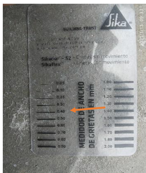
Imagen 23 Fisura de 0.1 medido con la regla de fisura con una resistencia de 140kg/cm 2 Patrón
