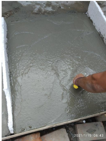
Imagen 10 Frotachar la superficie.
