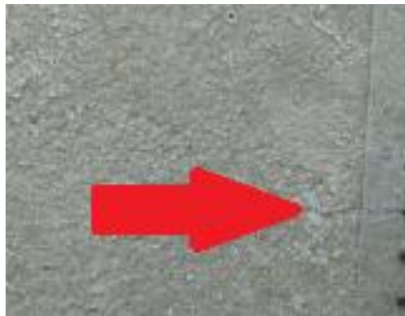
Imagen 25 Fisura de 0.25 medido con la regla de fisura con una resistencia de 140kg/cm2 Patrón
