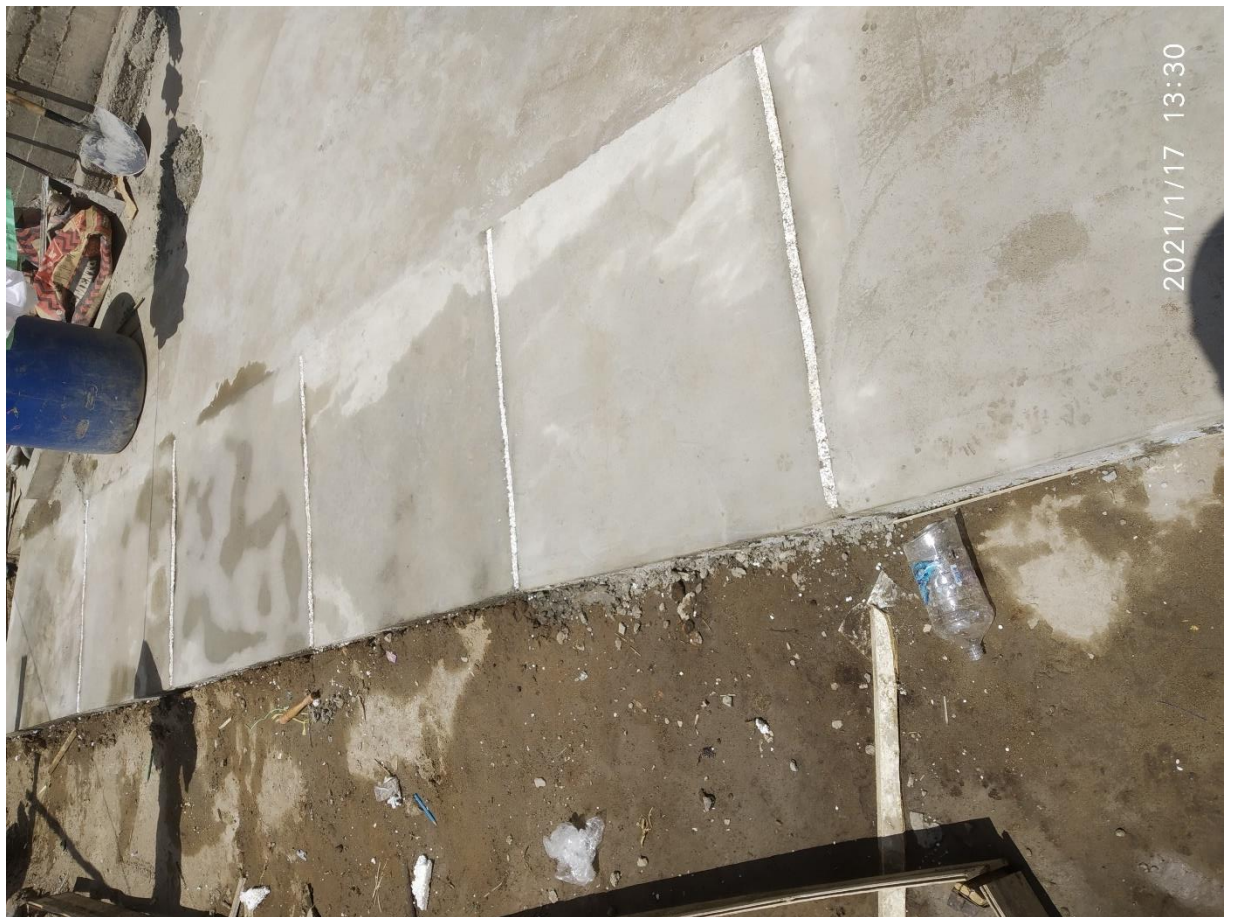
Imagen 17 3 Losas de concreto Patrón y 3 Losas de concreto con Sika Fiber
