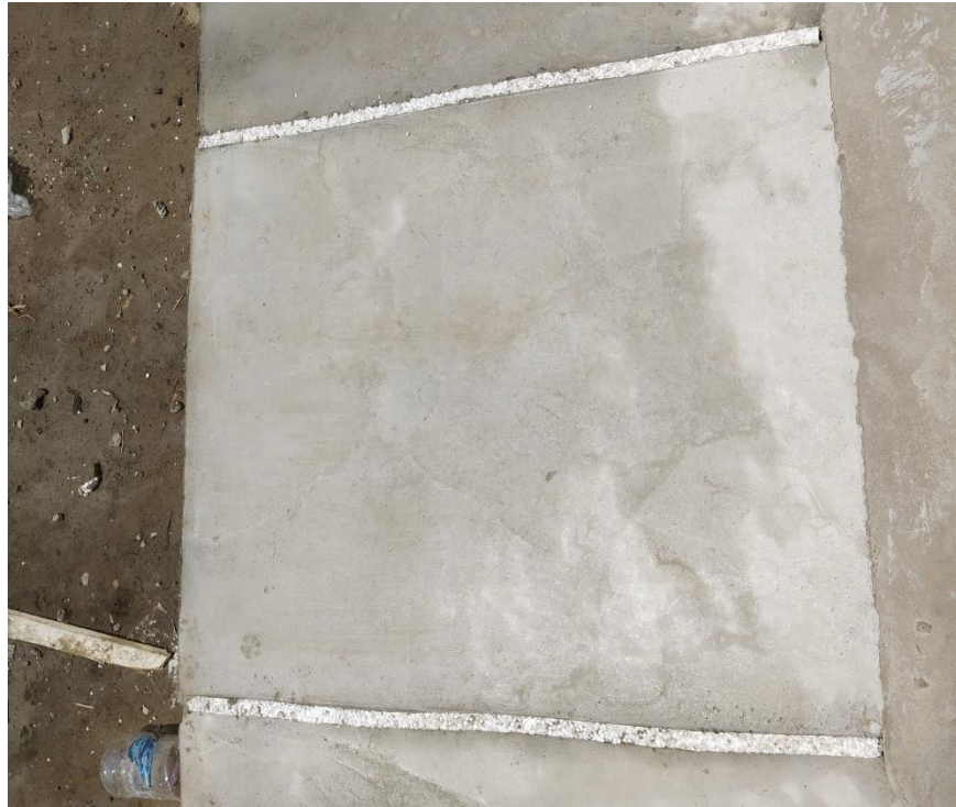
Imagen 15 Losa de concreto con diseño de 2100kg/cm 2 - con Sika Fiber
