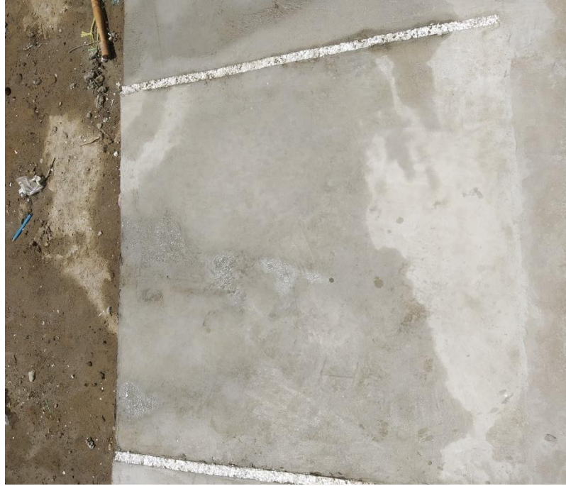
Imagen 14 Losa de concreto con diseño de 140kg/cm 2 - con Sika Fiber
