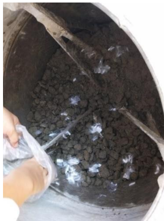
Imagen 33 Echando el Aditivo Sika Fiber al concreto.
