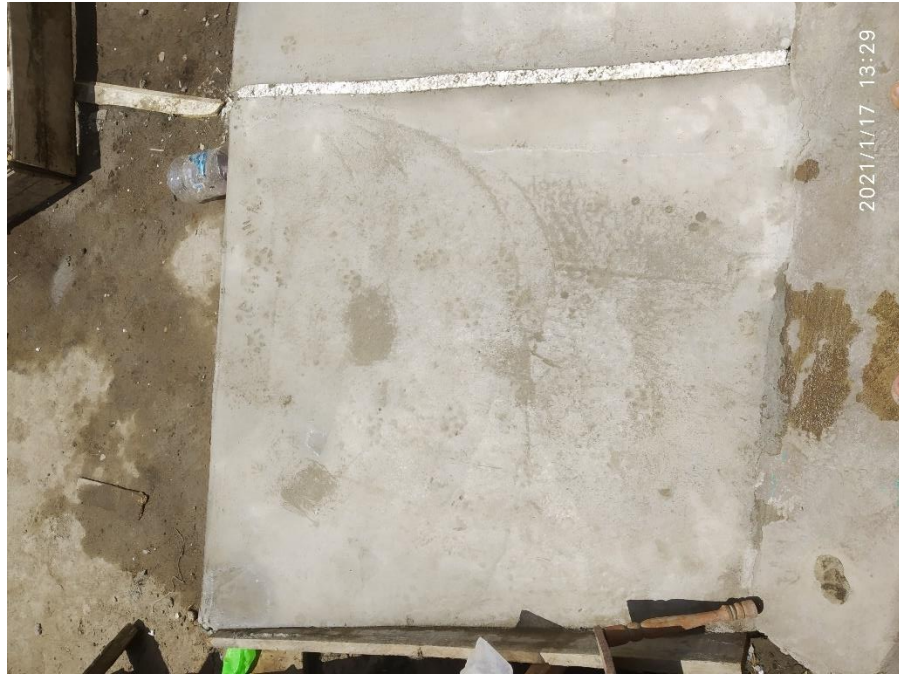
Imagen 16 Losa de concreto con diseño de 350kg/cm 2 - con Sika Fiber
