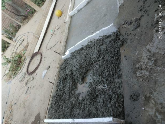
Imagen 9 Colocar el concreto.
