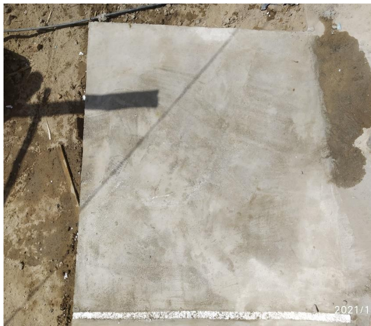
Imagen 10 Frotachar la superficie.
