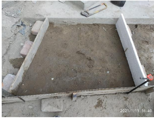
Imagen 6 Encofrado de un 1x1x0.10m
