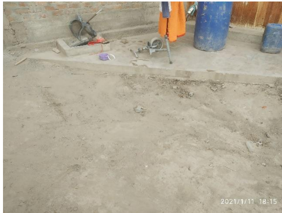
Imagen 4 Limpiar el lugar donde se va a colocar la losa.
