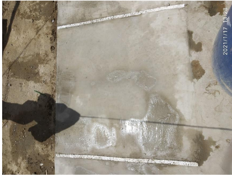
Imagen 12 Losa de concreto con diseño de 210kg/cm 2 - Patrón
