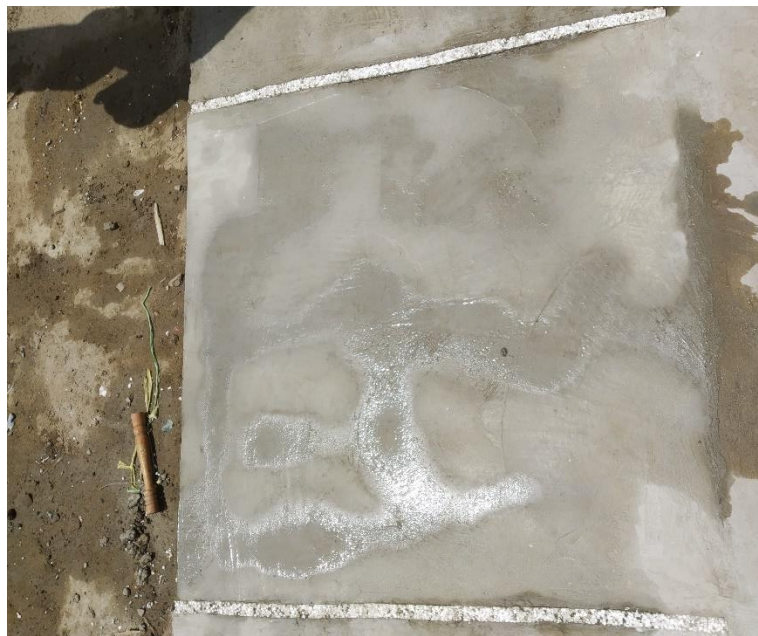
Imagen 13 Losa de concreto con diseño de 350kg/cm 2 - Patrón
