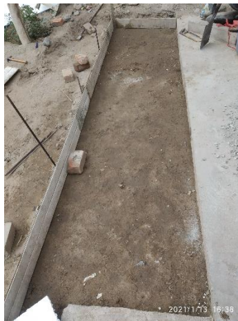
Imagen 5 Compactar el suelo.
