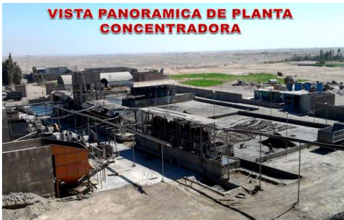
Fig. N° 09.- FOTOS DE PLANTA, CIRCUITOS DE CHANCADO Y RELAVES
