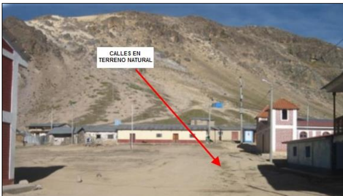
Figura 12. Edificaciones de material noble y calles sin pavimentar
