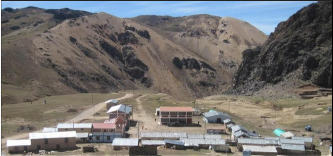
Figura 10. Vista Panorámica Del Anexo Pallancata
